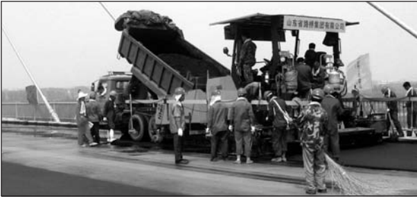
Bild 10: Einbau von Epoxy Asphalt auf der Brücke von Runyang [7]
