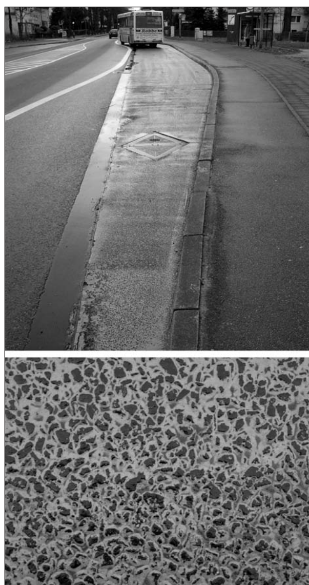
Bild 5: Halbstarre Deckschicht bei einer Bushaltestelle
