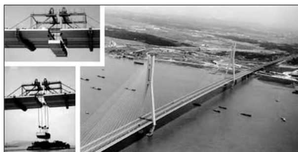
Bild 9: Brücke über den Yangtze bei Nanjing [6]
