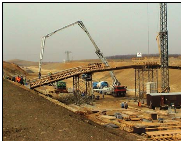
Bild 22: Trennung von Überbau und Bogen. Betonage der Bogenstiele
