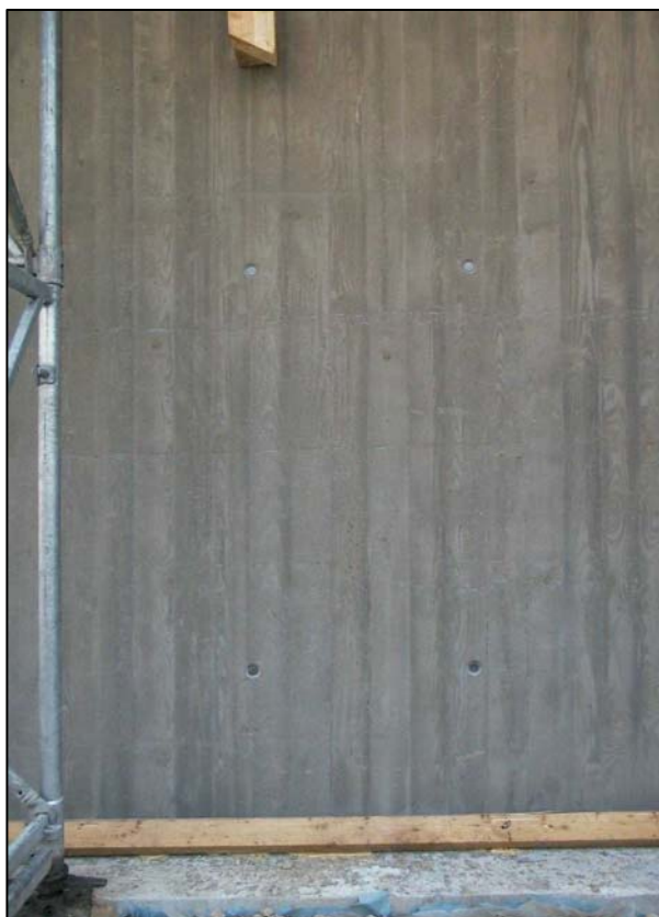
Bild 10: Sägerau geschalte Sichtbetonfläche
