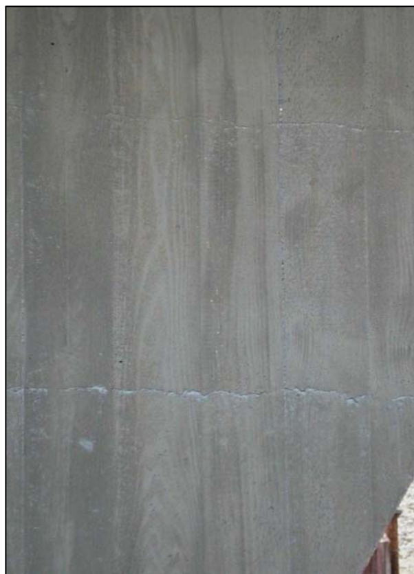
Bild 11: Betonierlagen
