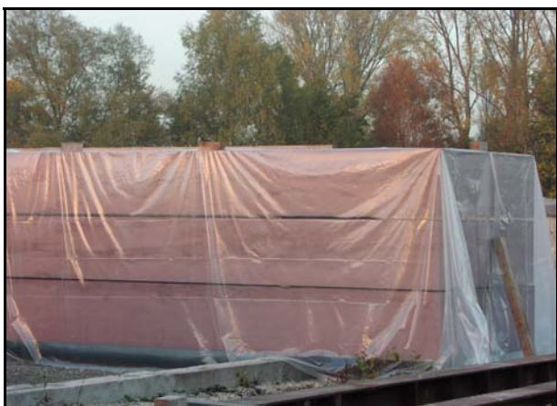
Bild 17: Nachbehandlung bis zum Betonalter von 7 Tagen
