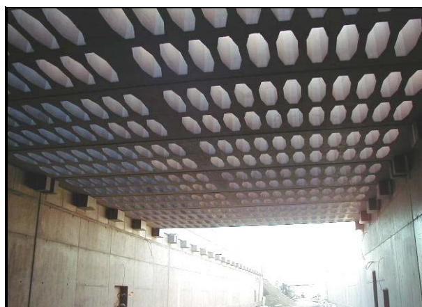
Bild 19: Rasterdecke Kappler Tunnel aus Fertigteilen mit Portlandschieferzement „Terrament“
