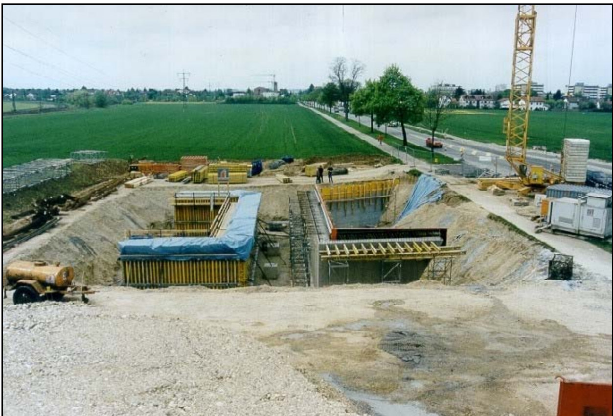
Bild 8: Widerlager der Geh- und Radwegunterführung bei Aubing nach der Betonage
