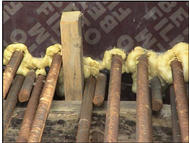
Bild 27: Abdichtung der Anschlussbewehrung am Hochpunkt
