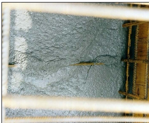
Bild 5: Vollständige Umhüllung der Bewehrung durch den SVB
