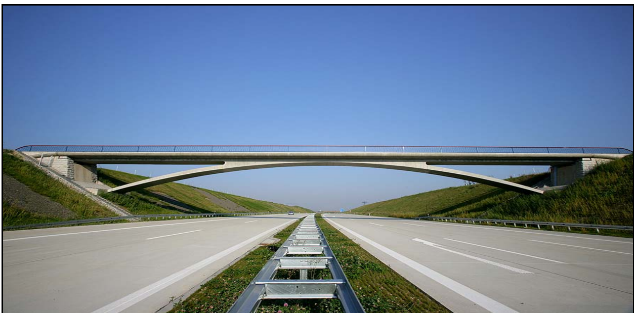
Bild 38: Bogenbrücke bei Wölkau mit SV-Beton B 65 und hochfestem Beton B 65 (Fotograph Jörg Riethausen, Chemnitz)
