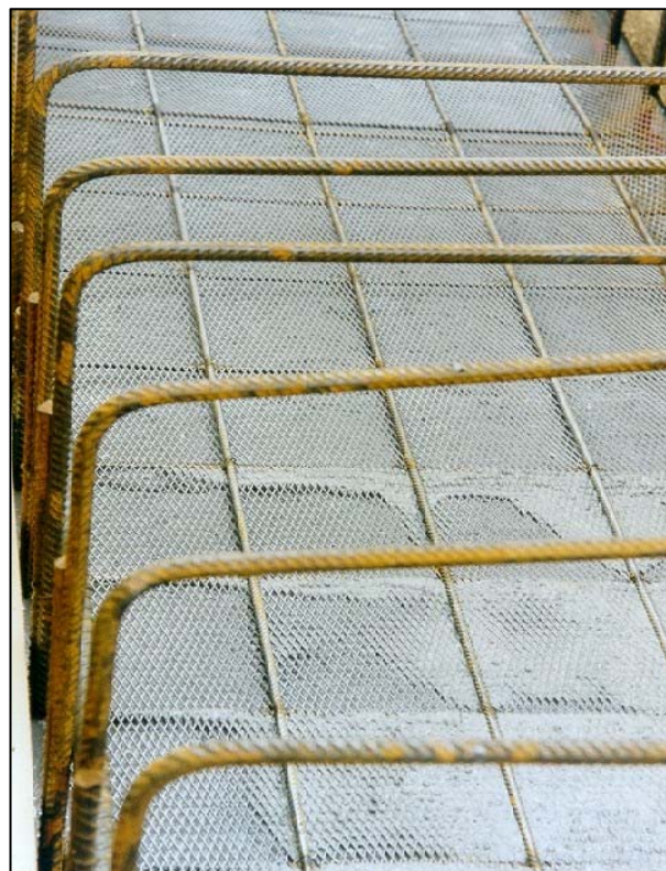
Bild 6: Herstellen der Oberflächenneigung von 2.7 %
