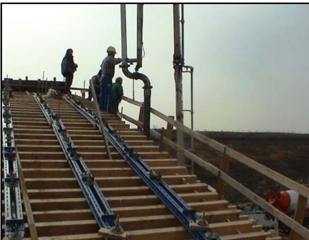
Bild 26: Schalung der Bogenstiele (Konterschaltung Fa. DOKA)
