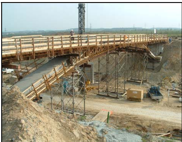
Bild 23: Trennung von Überbau und Bogen. Schalung des Überbaus über den fertigen Bogenstielen (Foto: Bechert+Partner)
