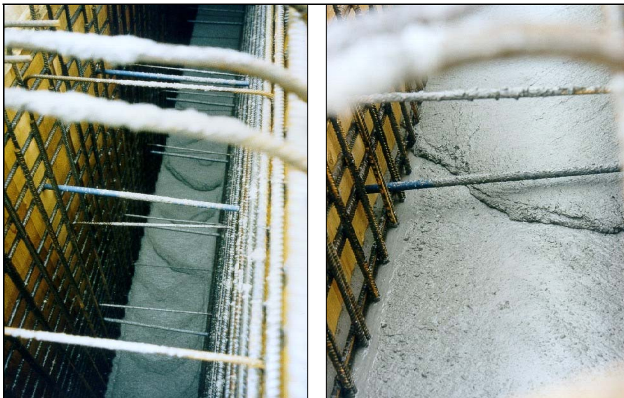
Bild 4: Fließverhalten des Frischbetons in der Schalung
