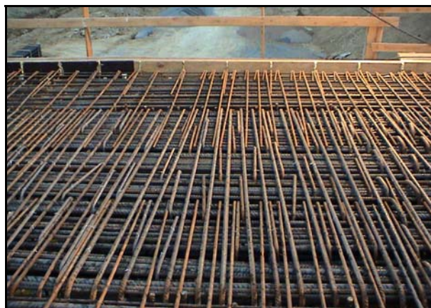
Bild 25: Engliegende Bewehrung im Bereich des Lückenschlusses
