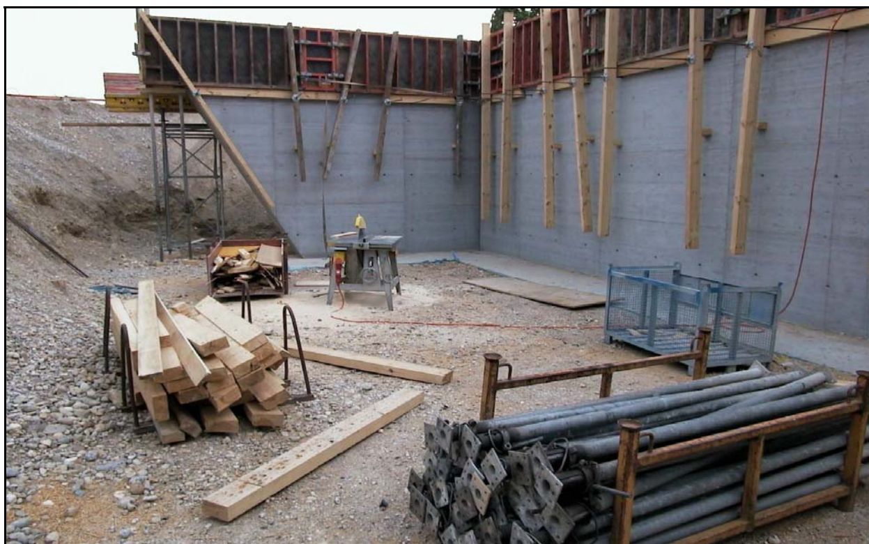
Bild 9: Aufgehende Widerlagerwand
