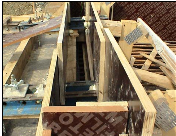
Bild 28: Schalungsaufsatz am Hochpunkt der Bogenschalung (Betoniertrichter)
