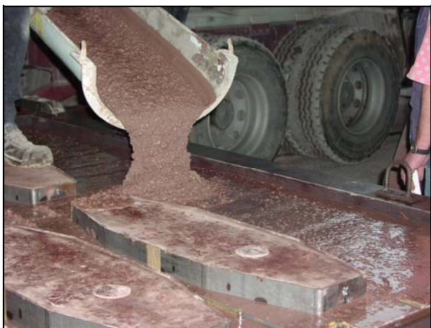
Bild 16: Betonage eines Fertigteils
