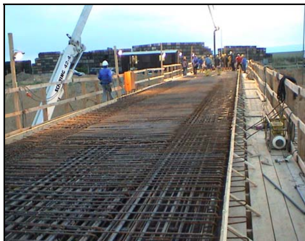
Bild 24: Ansicht der oberflächennahen Bewehrung des Überbaus. In der Mitte ist der Bereich des Lückenschlusses zwischen Bogenstielen und Überbau
