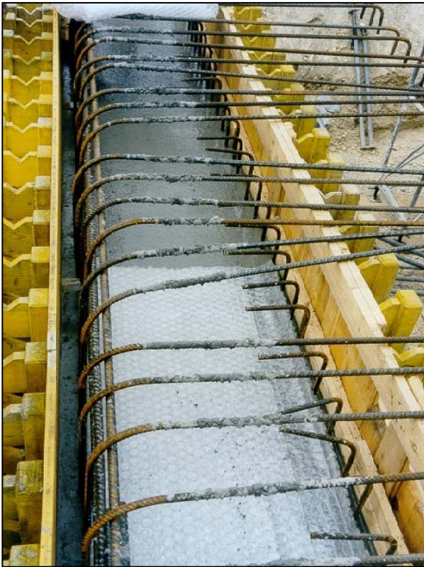
Bild 7: Wärmedämmung der freien Oberfläche
