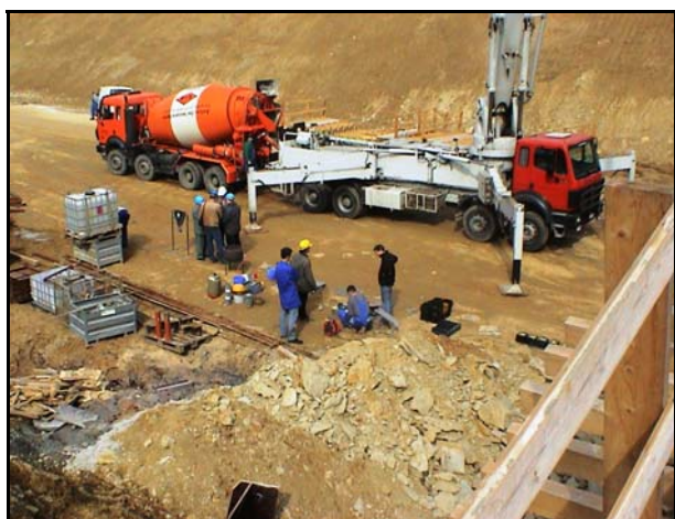
Bild 30: Frischbetonprüfungen auf der Baustelle. Von links: Trichter zur Bestimmung der Auslaufzeit, Ausrüstung für Darr-Versuch, Ausbreittisch für Setzfließmaß und Fließzeit, Probekörperformen
