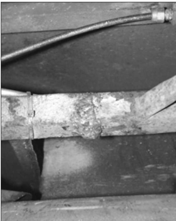
Bild 4.2: Längsträger hinten links: stumpf zusammengesweißt und korrodiert
