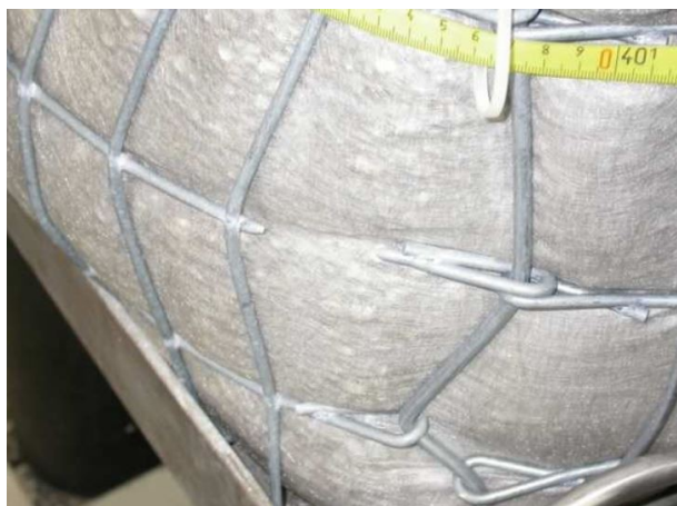
Bild 8: gerissener Draht bei Versuch 3 (aus: [6])
