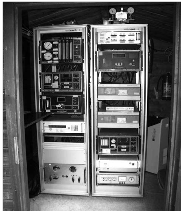
Bild 3.1: Einsicht in eine der Messstationen an der A 4
