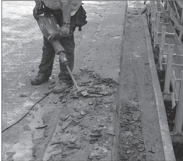
**Bild 8:** Abbruch der Schubschwelle im Zuge der Instandsetzung Sudbachtalbrücke
