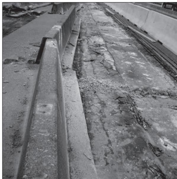
**Bild 7:** Freigelegte Schubschwelle im Zuge der Instandsetzung Talbrücke Rahmede
