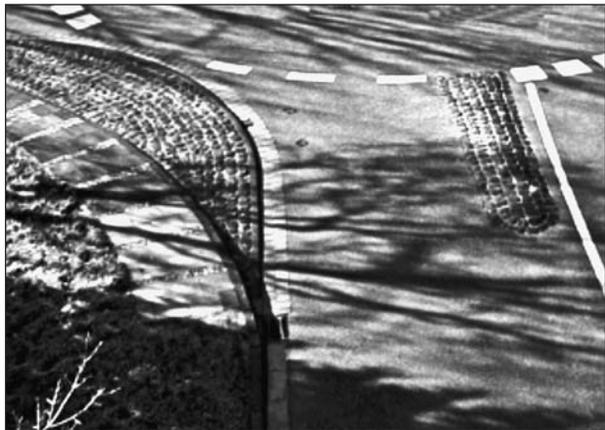
**Bild 3:** Sicherstellung der Befahrbarkeit durch befestigte Flächen außerhalb der Fahrbahn (FGSV, 2006c)
