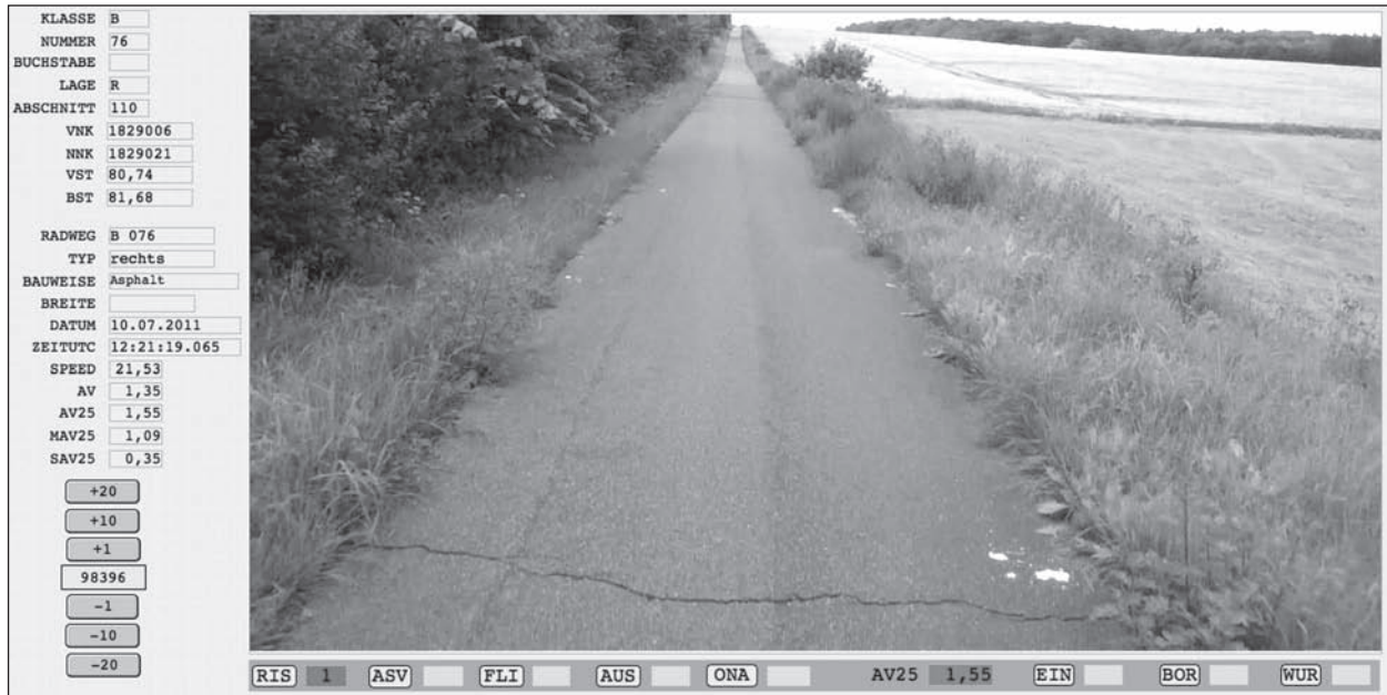
Bild 7-14: Beispiel für Radweg Typ „rechts“ der Bauweise Asphalt mit Riss
