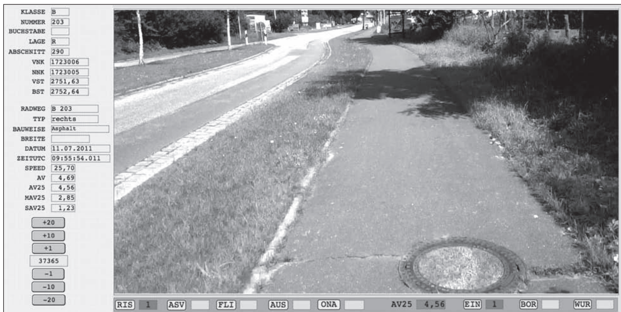
Bild 7-25: Beispiel für Radweg Typ „rechts“ der Bauweise Asphalt mit Einbau und Riss
