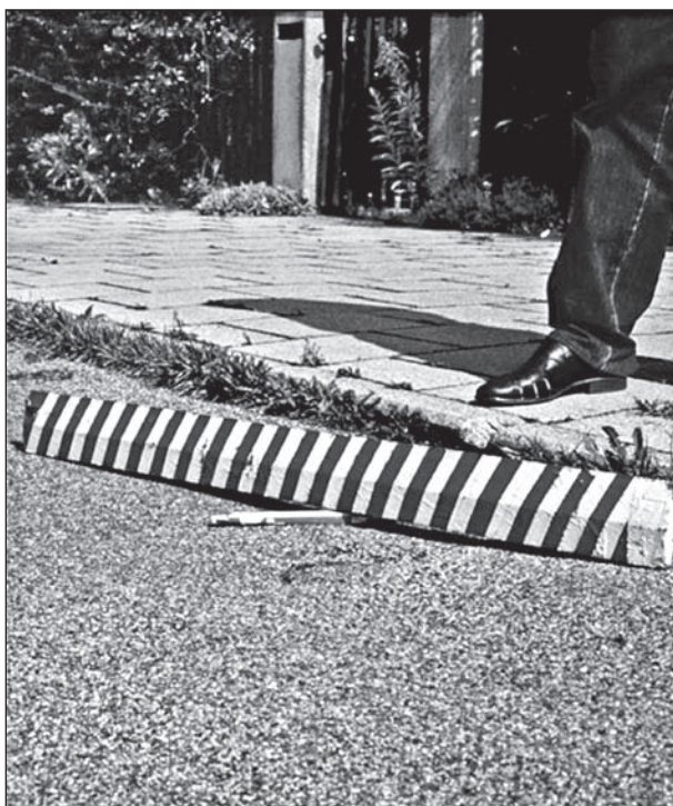
Bild 3-1: Mulden-/wellenartige Verformung
