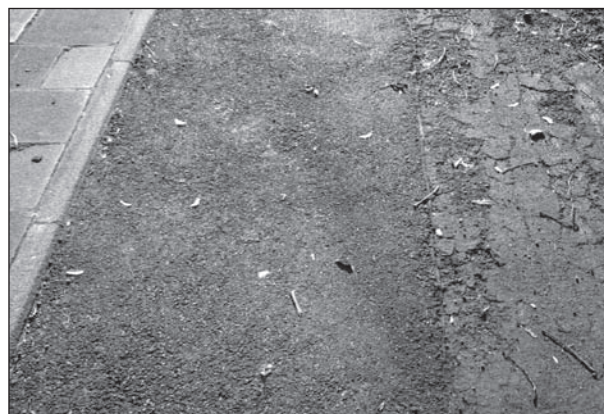
Bild 3-5: Ausmagerung, Splittverlust
