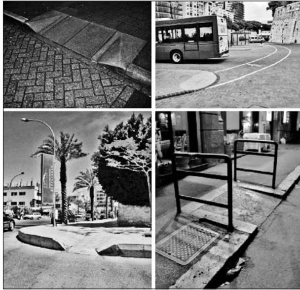
Bild 28: Bordsteinabsenkungen auf Fahrbahnniveau in den Niederlanden, Gibraltar, Jordanien und Italien (BÖHRINGER 2010a, S. 2)
