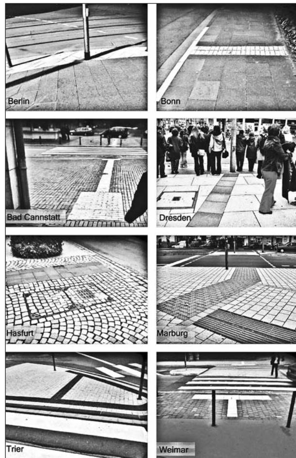
Bild 3: Varianz von Bodenindikatoren an Überquerungsstellen in Deutschland – Beispiele (GATHER et al. 2006, S. 230)
