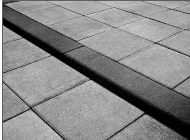
Bild 97: Bordstein mit einer Ausrundung von r = 2 cm und einer Einbauhöhe von 3 cm
