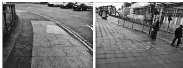
Bild 36: Korrekt verlegte Bodenindikatoren an Überquerungsstellen in Plymouth, England (links: ohne LSA; rechts: LSA-gesichert)
