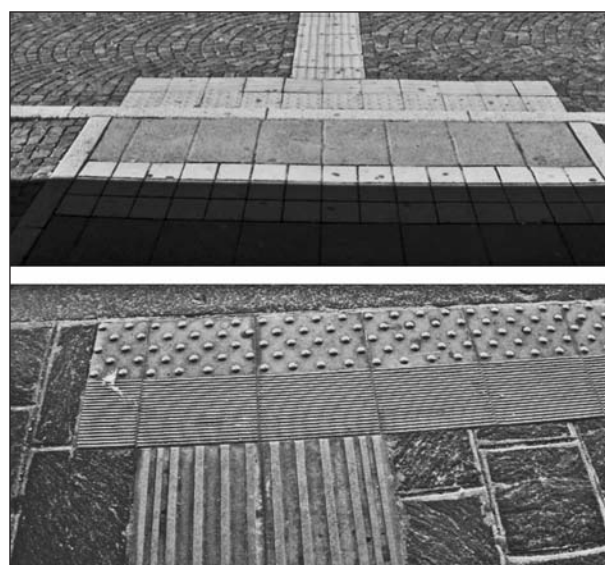
Bild 9: Überquerungsstellen in Asti (Italien) von der Fahrbahn aus gesehen (oben) und vom Gehweg aus gesehen (unten)
