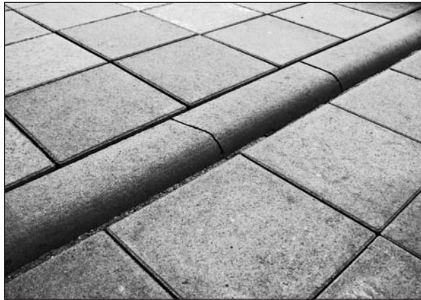
Bild 56: Abgerundeter Bordstein ( R = 5\text{ cm} ) mit einer Auftritts­höhe von 3 cm (hier in der Teststrecke eingebaut)
