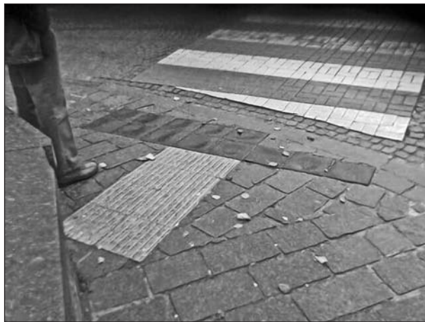
Bild 25: Witterungsbedingte Bodenhaftungsprobleme bei „Weichdallen“ an einer Überquerungsstelle in Brügge, Belgien
