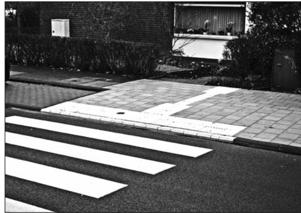
Bild 57: Schräger Bordstein als Standardbauweise an einer Überquerungsstelle
