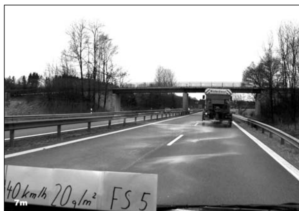
Bild 20: Ausbringung von Siedesalz mit Streumaschine Typ STA 95 der Firma Küpper-Weisser mit Anfeuchtungsgrad 5 bei 40 km/h, 7 m Streubreite und 20 \text{ g/m}^2 Streudichte
