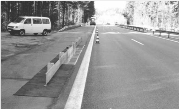
Bild 37: Vorrichtung für das Auffangen von Verwehverlusten bei der Tausalzausbringung
