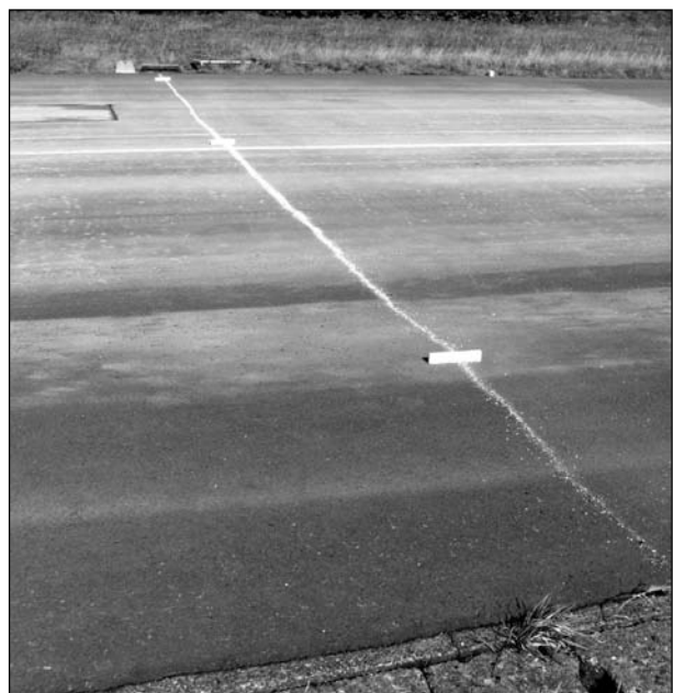
Bild 11: Tausalz zusammengekehrt längs der Fahrtrichtung über 10 m Länge, Streudichte: 20 g/m 2 , Fahrgeschwindigkeit nicht simuliert
