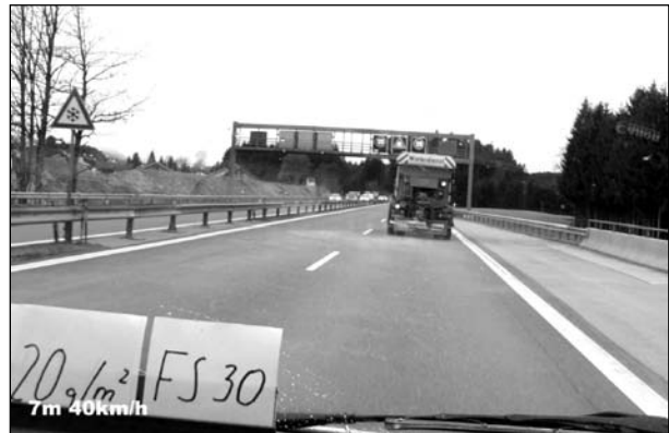
Bild 25: Ausbringung von Siedesalz mit Streumaschine Typ STA 95 der Firma Küpper-Weisser mit Anfeuchtungsgrad 30 bei 40 km/h, 7 m Streubreite und 20 g/m 2 Streudichte
