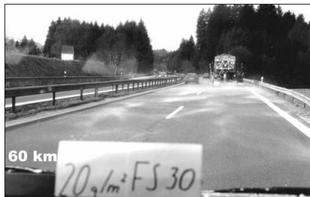
Bild 36: Ausbringung von Siedesalz mit Streumaschine Typ 6002 der Firma Beilhack mit Anfeuchtungsgrad 30 bei 60 km/h, 7 m Streubreite und 20 g/m 2 Streudichte
