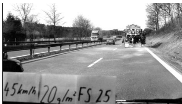
Bild 33: Ausbringung von Siedesalz mit Streumaschine Typ 6002 der Firma Beilhack mit Anfeuchtungsgrad 25 bei 45 km/h, 7 m Streubreite und 20 g/m 2 Streudichte
