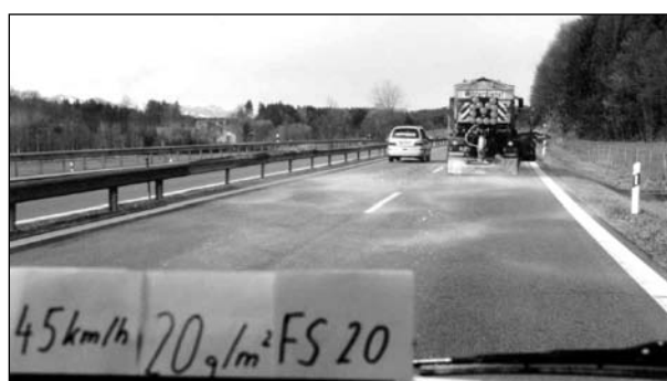
Bild 32: Ausbringung von Siedesalz mit Streumaschine Typ 6002 der Firma Beilhack mit Anfeuchtungsgrad 20 bei 45 km/h, 7 m Streubreite und 20 g/m 2 Streudichte
