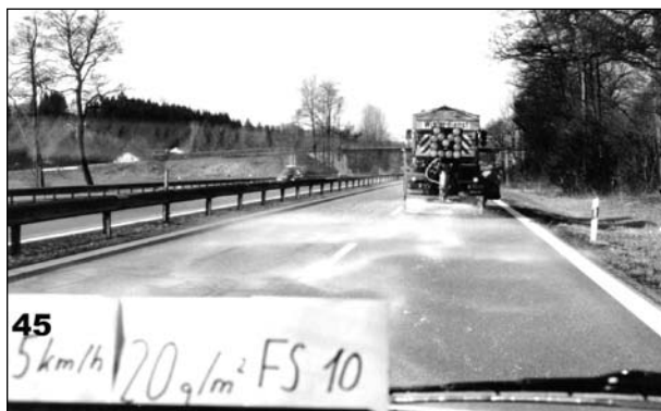
Bild 30: Ausbringung von Siedesalz mit Streumaschine Typ 6002 der Firma Beilhack mit Anfeuchtungsgrad 10 bei 45 km/h, 7 m Streubreite und 20 g/m 2 Streudichte
