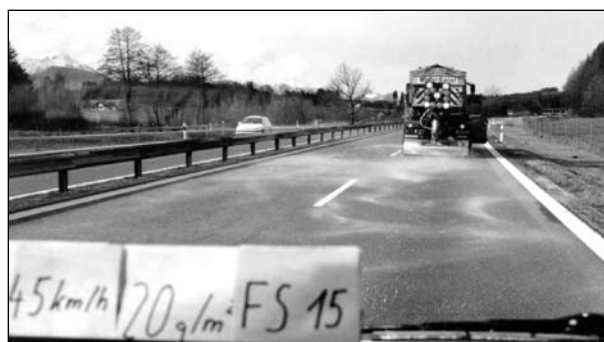
Bild 31: Ausbringung von Siedesalz mit Streumaschine Typ 6002 der Firma Beilhack mit Anfeuchtungsgrad 15 bei 45 km/h, 7 m Streubreite und 20 g/m 2 Streudichte
