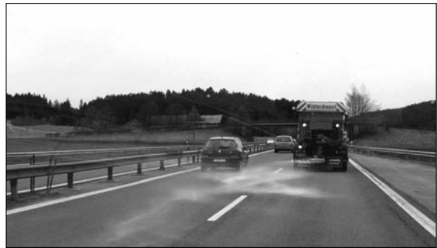
Bild 9: Ausbringen von trockenem Siedesalz bei einer Fahrgeschwindigkeit von ca. 40 km/h (20 g/m 2 Streudichte, 8 m Streubreite)
