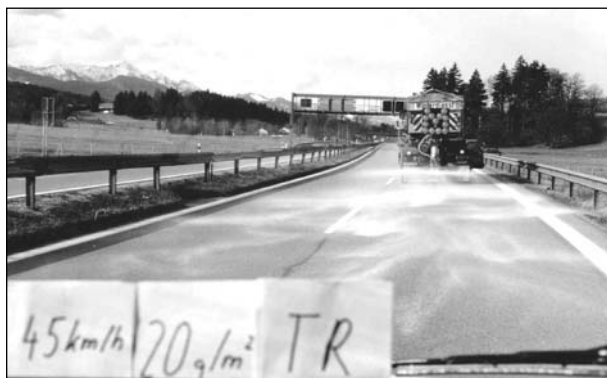
Bild 28: Ausbringung von Siedesalz mit Streumaschine Typ 6002 der Firma Beilhack ohne Anfeuchtung bei 45 km/h, 7 m Streubreite und 20 g/m 2 Streudichte
