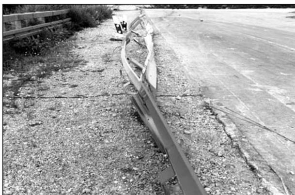
**Bild 85:** Schäden am System – Ansicht in Anfahrrichtung
