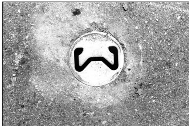
**Bild 4:** Ansicht einer im Bohrloch versenkten Rohrhülse von oben
