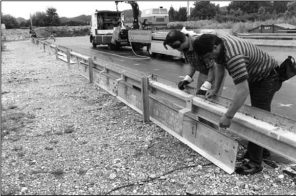
**Bild 54:** Montieren des Unterfahrschutzes (Typ „Euskirchen“) an das System ESP 4,0
