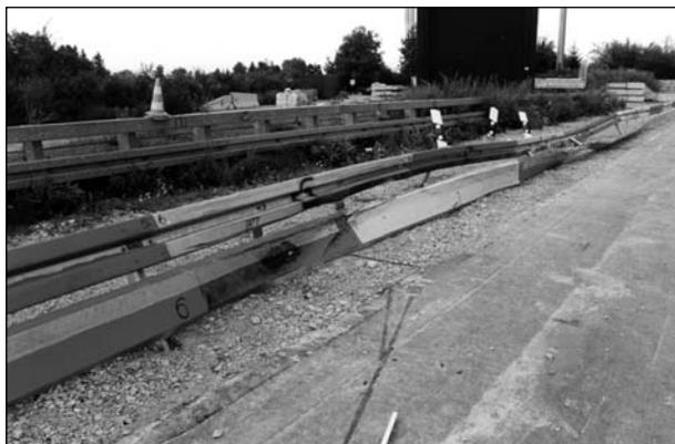
**Bild 84:** Anprallspuren an der Kontaktstrecke
