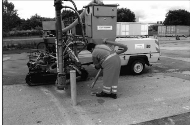
**Bild 3:** Bohren der Löcher für die Rohrhülsen (im Vordergrund exemplarisch 1 Rohrhülse)
