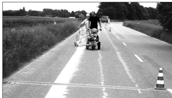
Bild 27: Applizierung der Farbmarkierung mittels Sprühwagens
