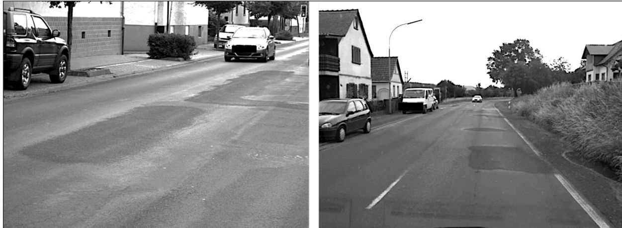
Bild 27: Vor fünf Wochen durchgeführte Reparaturarbeiten mit dem RRP
