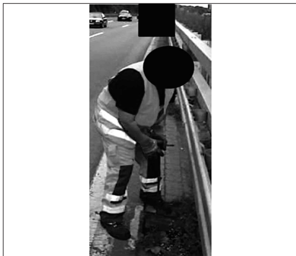
Bild 38: Ablaufreinigung durch einen Mitarbeiter mit Schachthaken
