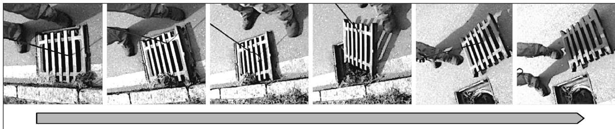
Bild 43: Schwierigkeiten bei der Positionierung von Schachthaken am Ablaufdeckel
