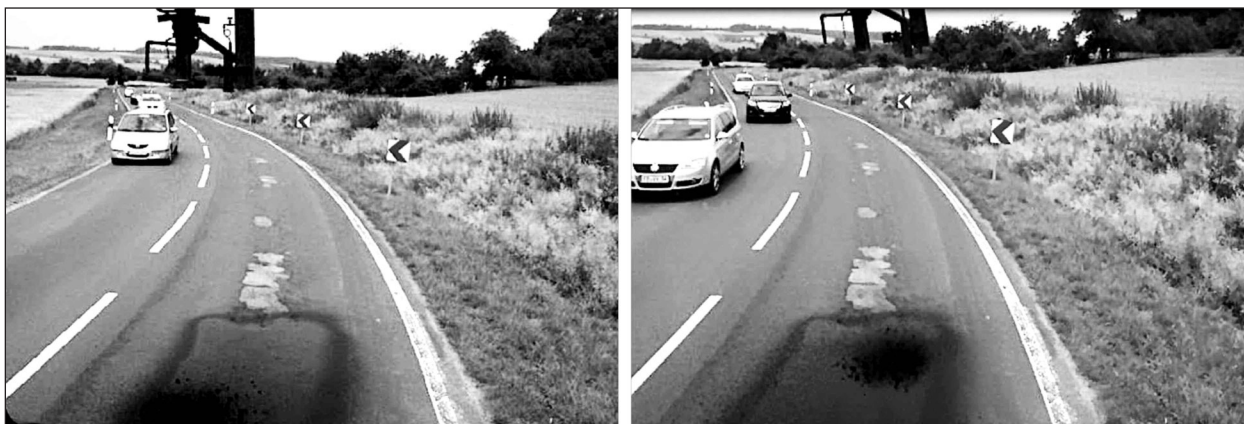
Bild 26: Ausbringen von Splitt
