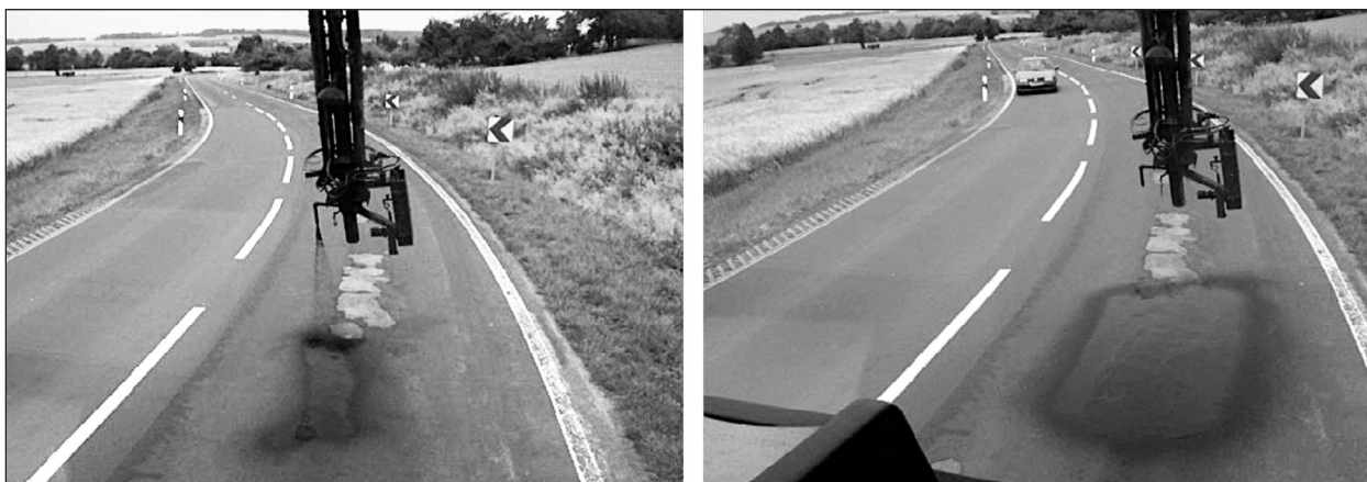
Bild 25: Ausbringen von Emulsion
