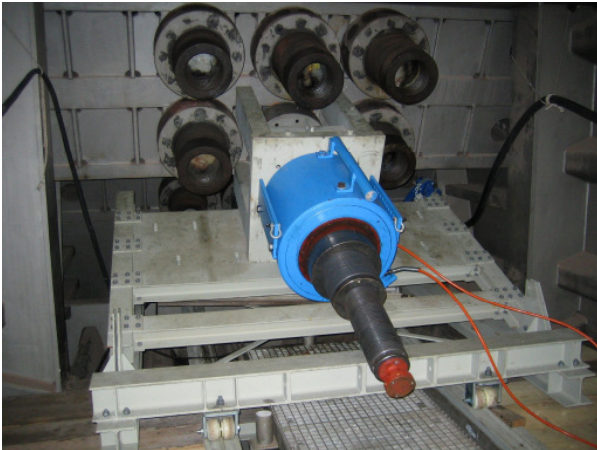
Bild 16: Lösen der Stützmutter am Spannanker [6]
