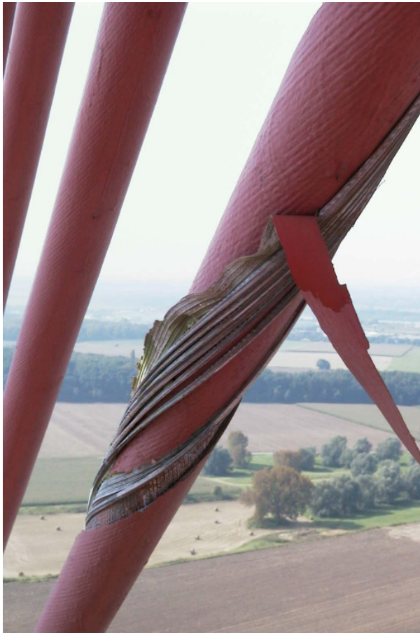
Bild 15: Offene Drahtbrüche
