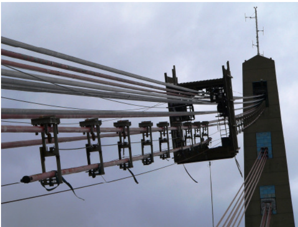
Bild 17: Ablassen eines Seilstücks
