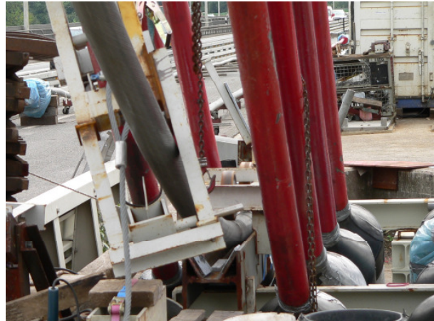
Bild 18: Einziehen des neuen Seils
