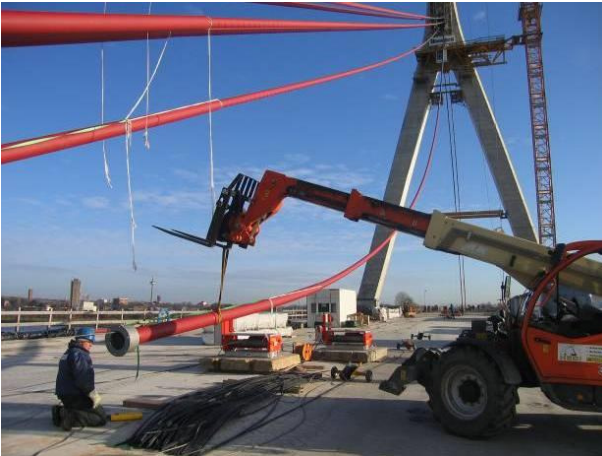
Bild 28: Einheben der Verrohrung [2]
