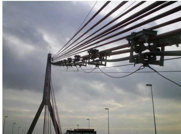
Bild 19: Hochziehen eines neuen Seils
