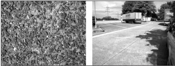
**Bild 77:** Messstelle 7, BAB A 44, Rasthof Soester Börde, Süd, Waschbeton ohne Besenstrich, dunkle Steine
