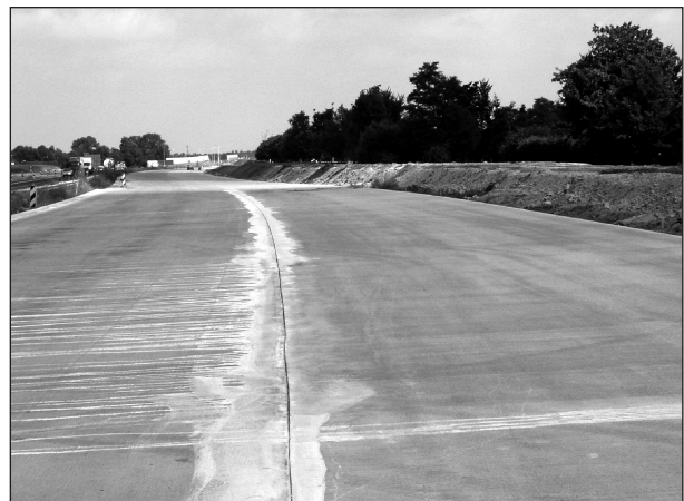
Bild 3: A 50 Veghel/NL, Betonoberbau als Grundlage für OPA
