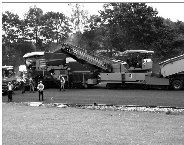
Bild 8: Kompaktmodulfertiger und Beschicker
