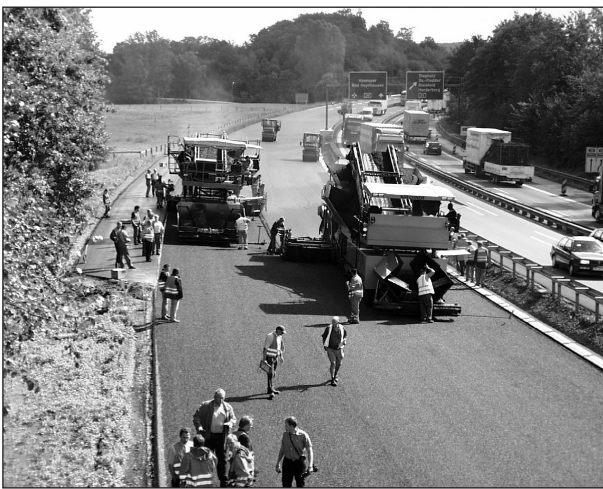
Bild 7: Kompakteinbau mit zwei Fertigern
