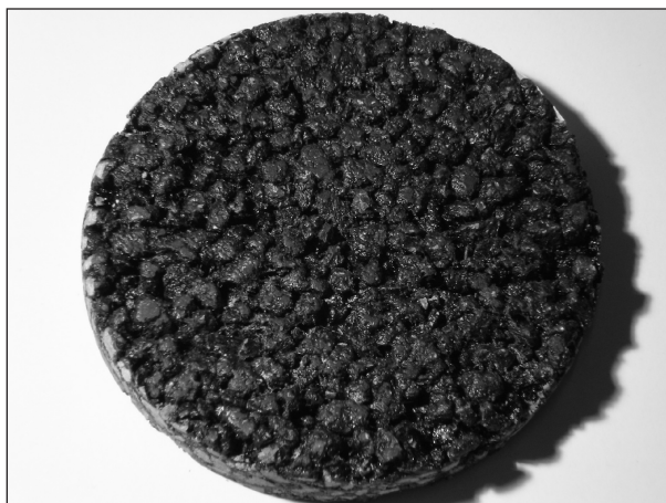
Bild 12: Oberfläche Bohrkern konventioneller Einbau Profil 2
