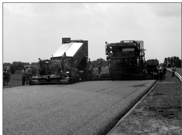
Bild 4: A 50 Veghel/NL, Einbau OPA mit Kompaktfertiger (im Bild rechts)
