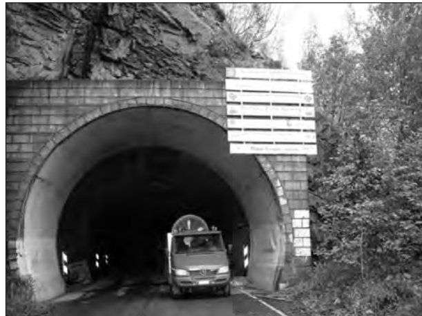
Bild 4-46: Ostportal des Runehamar-Tunnels [24]
