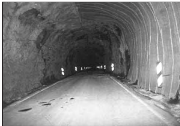
Bild 4-47: Tunnelröhre des Runehamar-Tunnels [25]
