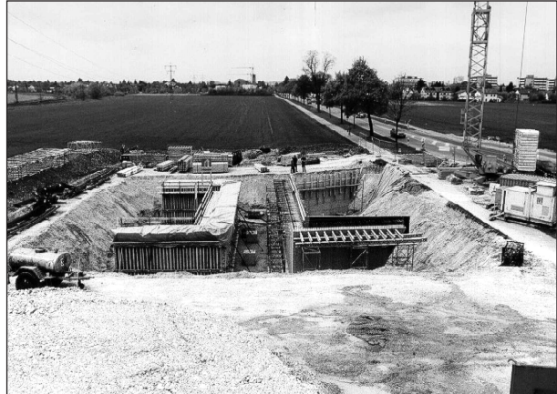
Bild 32: Aufsicht auf die Geh- und Radwegunterführung bei Germering
