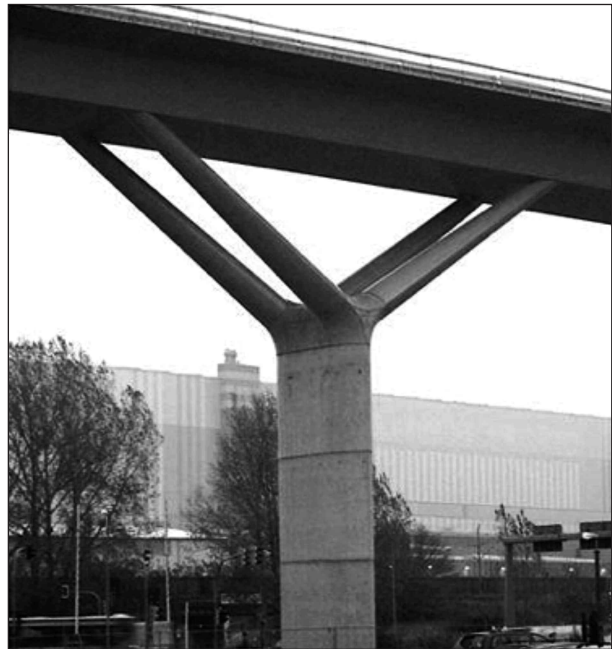
Bild 39: Pfeilerkopf der 2. Strelasundquerung mit SVB
