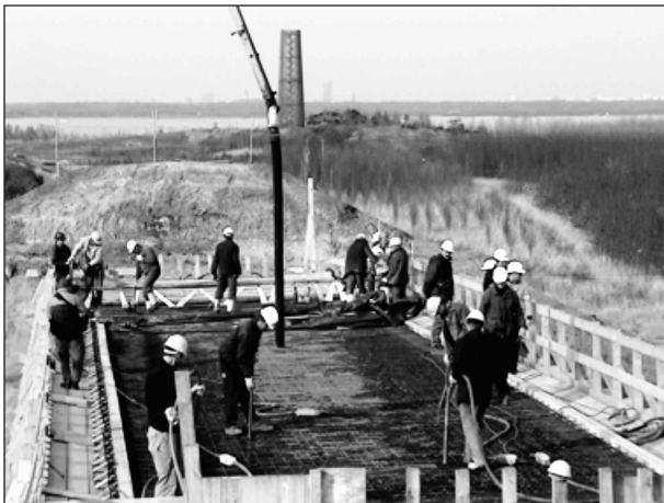
Bild 19: Nachbehandlungskonzept, noch ohne Wärmedämmmatten
