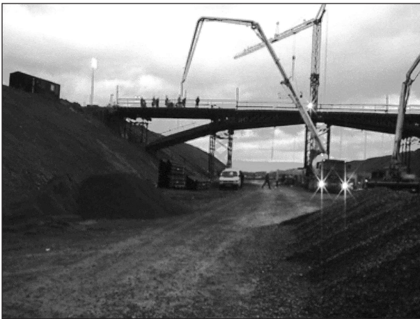
Bild 12: Nachtbetonage des Überbaus der Bogenbrücke Wölkau mit B65
