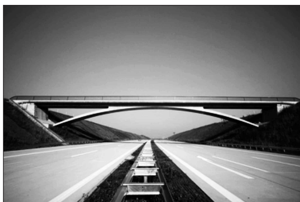
Bild 16: Bogenbrücke Wölkau, Überbau mit B65 (Fotograf Jörg Riethausen, Chemnitz)
