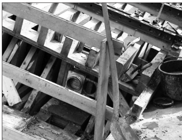
Bild 37: Einfüllstutzen für SVB mit Schieber
