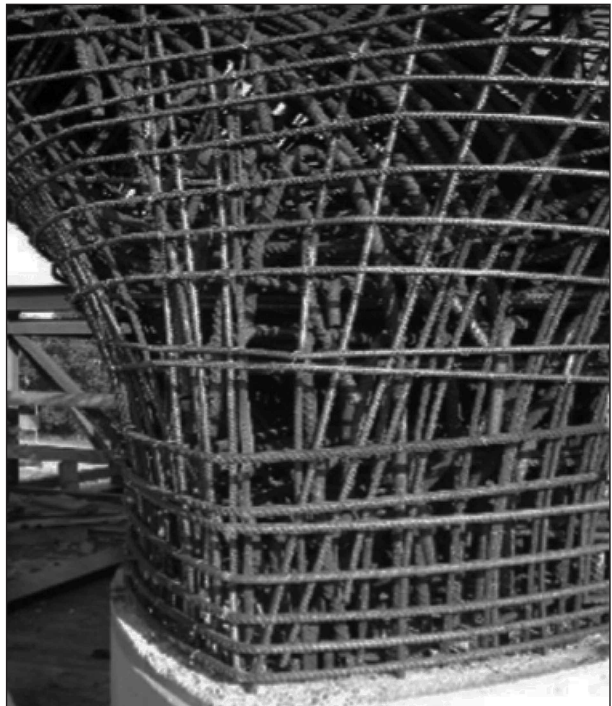
Bild 40: Bewehrung im Bereich der Schrägstreben [73]
