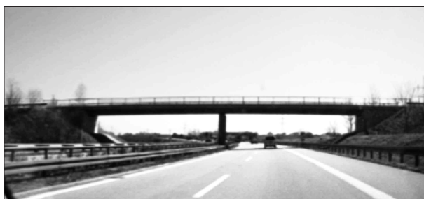
Bild 5: Überführung bei Buchloe nach 12 Jahren unter Verkehr. Foto: [32]
