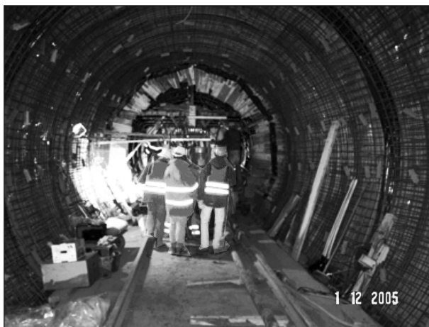
Bild 44: Blick auf die Betonage eines Blocks mit SVB im Rettungsstollen Schlossbergtunnel Dillenburg
