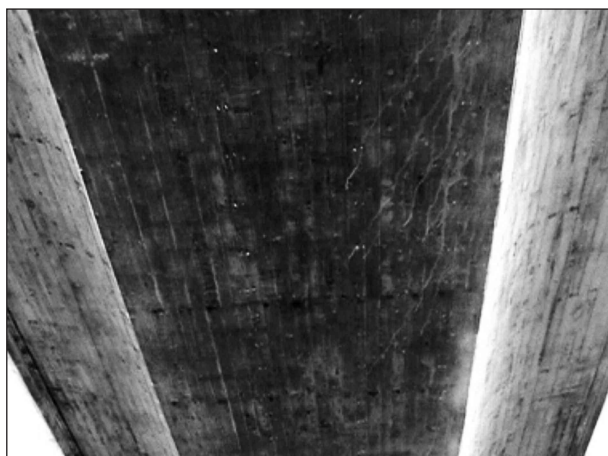
Bild 23: Untersicht des Überbaus BW 45.1 im Oktober 2005, ca. 7 Monate nach Herstellung
