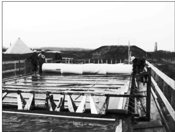
Bild 20: Auflegen der Wärmedämmmatten
