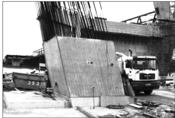
Bild 31: Probestück „Der Zeuge“ mit C55/67 für den Pylon der Niederrheinbrücke Wesel
