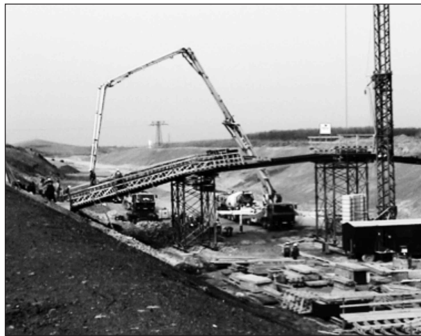
Bild 36: Betonage eines Bogenstieles
