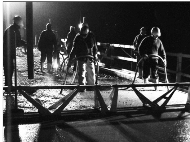
Bild 13: Verdichten des Überbaus der Bogenbrücke Wölkau mit B65
