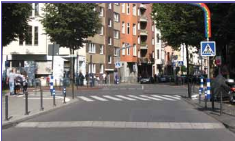
Beispiel für eine „Aufpflasterung“
