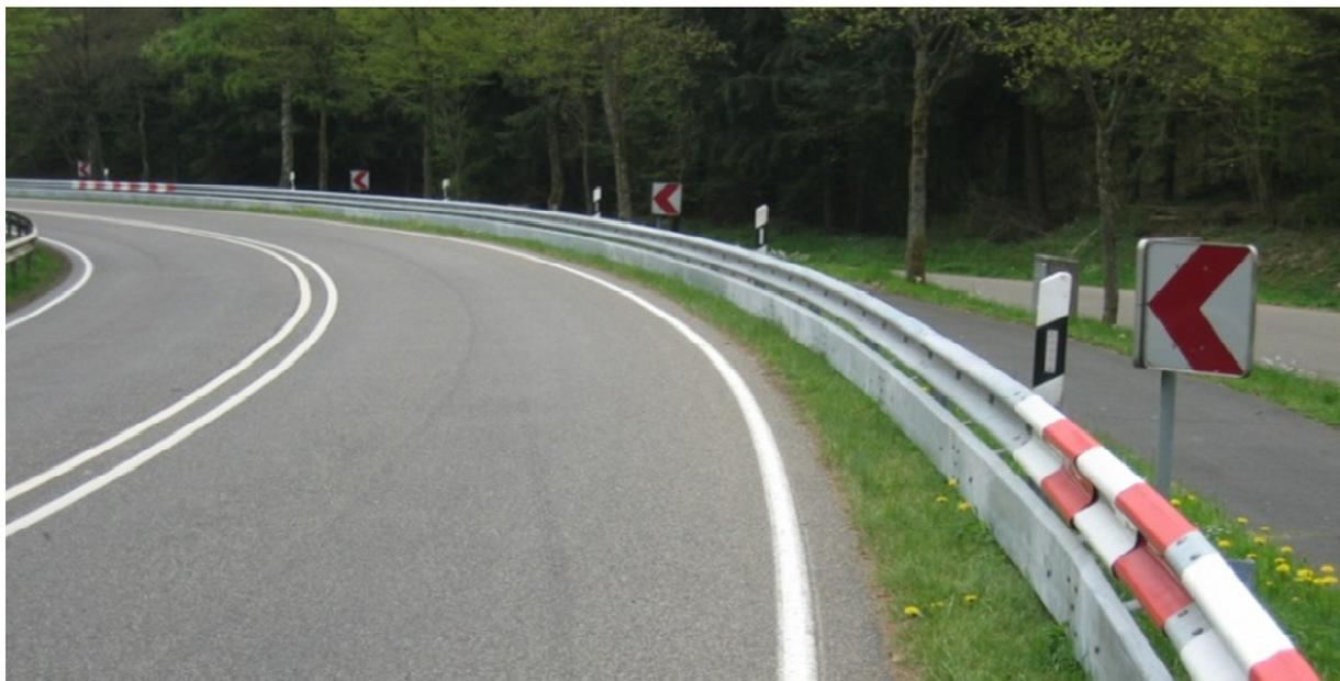
Abb. 16: Stahlschutzplanke mit Unterfahrschutz (Bild 21 aus MVMot)
