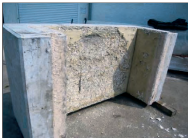
Bild 5: Probekörper aus Faserbeton (mit PP-Fasern) nach Großbrandversuch [10]
