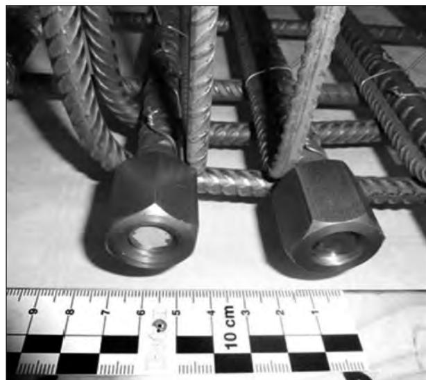
**Bild 16:** Bewehrungsdetail: Muttern zur Endverankerung der Biegezugbewehrung
