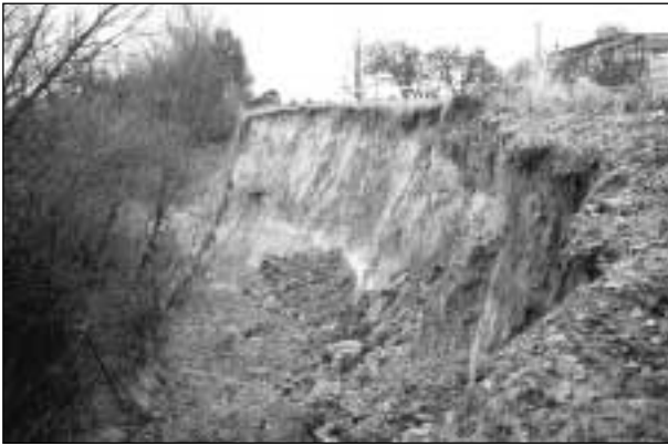
Bild 3: Rund 6 m hohe Abbruchkante in Löss und Sand
