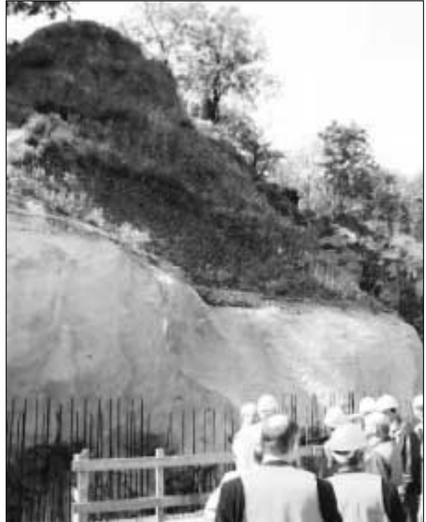
Bild 8: Übergang Weisseritztalbrücke-Tunnel Coschütz mit Sicherung Naturdenkmal
