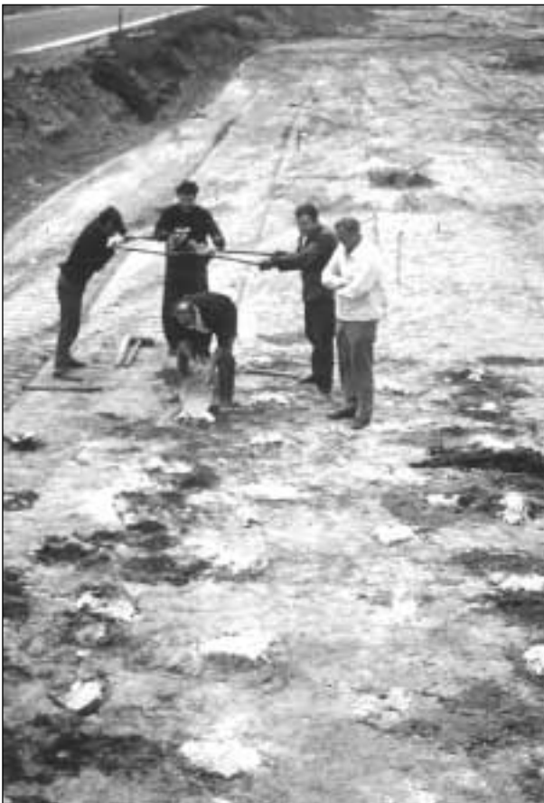
Bild 7: Händische Herstellung von Kalkpfählen im Bohrlochverfahren (L 3199 in Hessen 1964)
