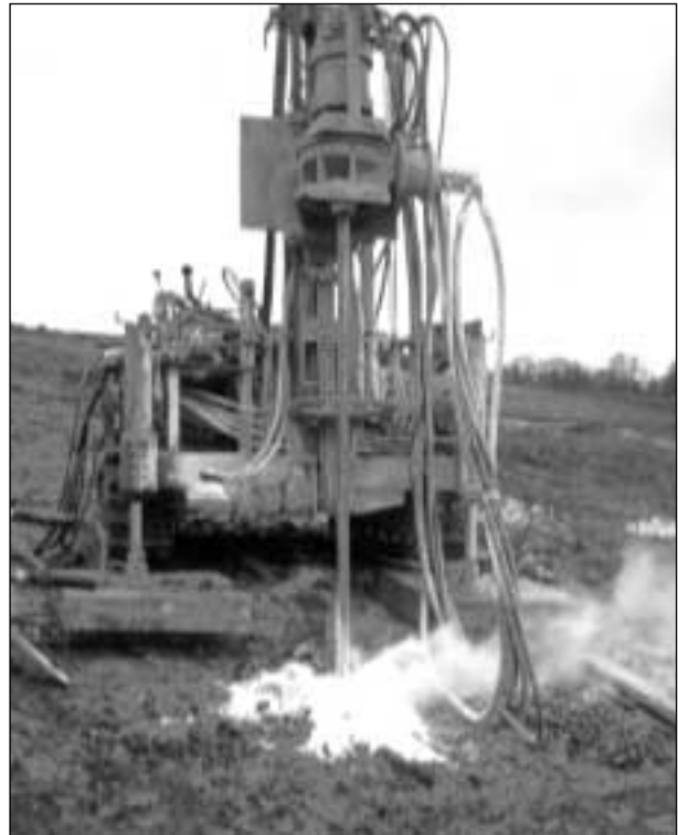
Bild 12: Herstellung von Kalk-Boden-Säulen mittels Vor- und Überbohren
