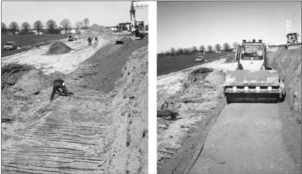
Bild 5: Auslegen und Einerden von Pflanzen auf einer Berme und Verdichten mit einer Vibrationswalze
