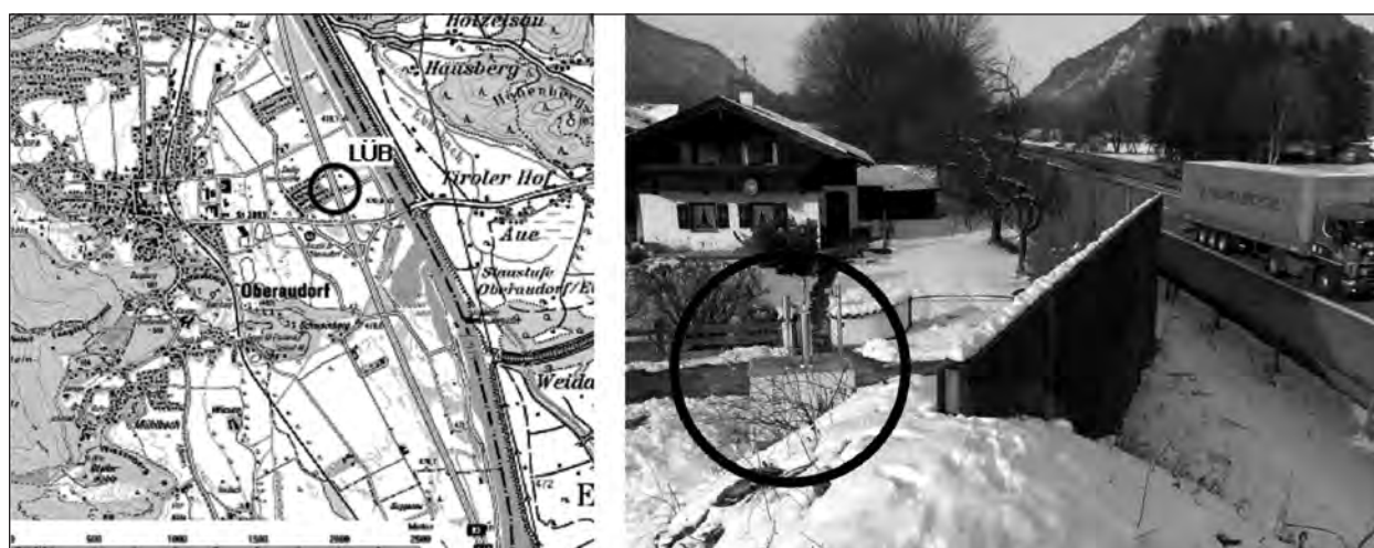
Bild 7.4: Lageplan und Bild von der Messstelle an der A 93 bei Oberaudorf (Quelle: LfU Bayern, 2009)
