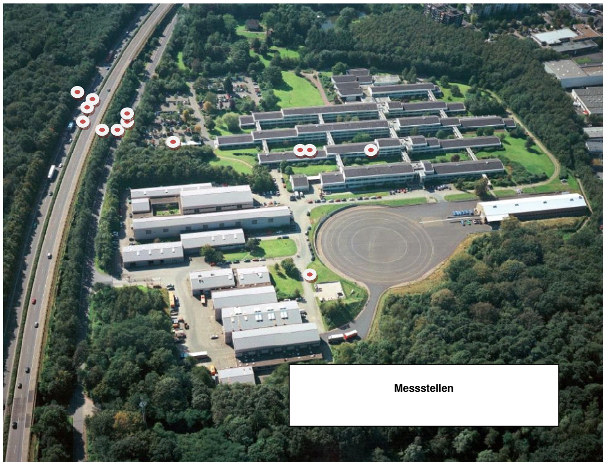
Abbildung: 3: Gesamtübersicht des an der Bundesautobahn A4 bzw. auf dem Gelände der Bundesanstalt für Straßenwesen gelegenen Messquerschnitts (Quelle: Google maps)
