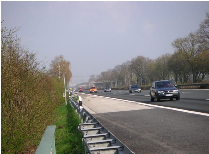
Abbildung 17: Messstellen PM x , NO x Messquerschnitt an der Bundesautobahn A555 in Richtung Bonn
