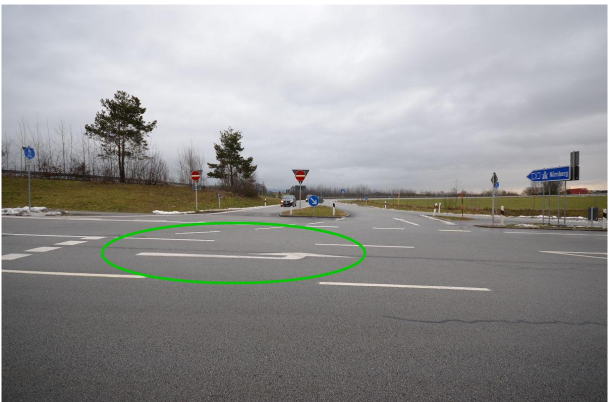
Abbildung 64: Optimierte Markierung an Anschlussstellen Ansicht 3 (Foto: Leven/Seipel)
