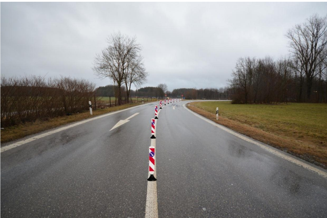
Abbildung 66: Beispiel für ungünstige optische Linienführung von Ein-/Ausfahrrampen - Mögliche Alternative? (Foto: Leven/Seipel)
