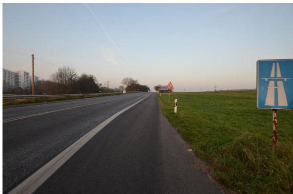
Abbildung 38: Mitteltrennung im Rampenbereich ist nicht vorhanden. Im Verlauf der Rampe besteht ein „Durchschuss“ zur Durchgangsfahrbahn zur Autobahn
