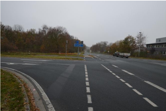
Abbildung 33: Vorgeschriebene Vorbeifahrt, rechts vorbei (Z 222) ist nicht „eingedreht“ und für den Linksabbieger spät oder nicht erkennbar
