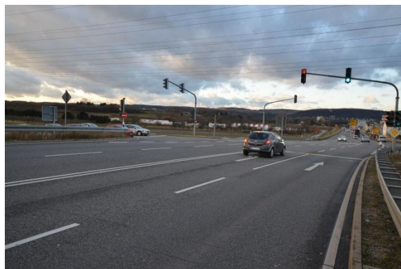
Abbildung 32: Pfeilwegweisung zur Autobahn (Z 430) fehlt zur Orientierung für den Linksabbieger
