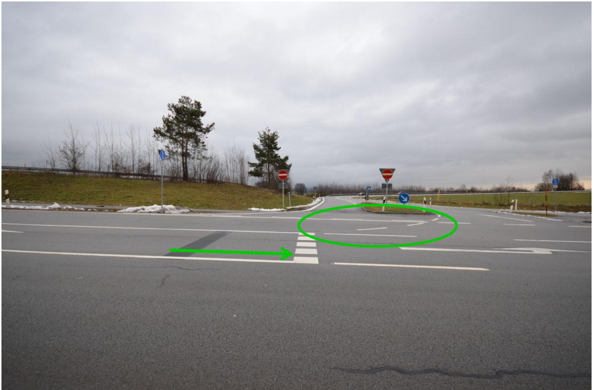
Abbildung 64: Optimierte Markierung an Anschlussstellen Ansicht 3 (Foto: Leven/Seipel)
