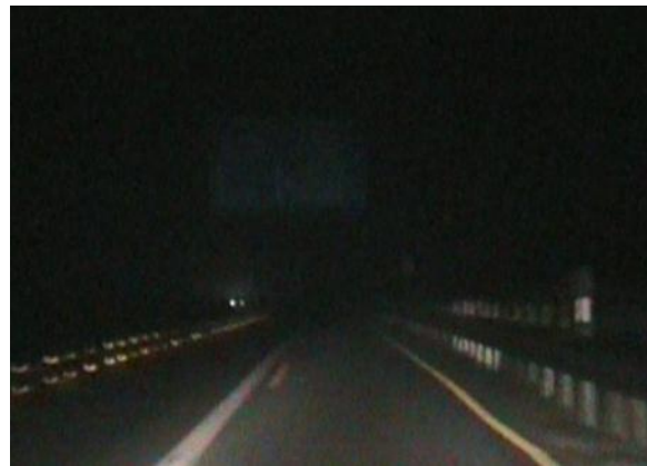
Abbildung 45: Beispiel für ungenügende Nachsichtbarkeit durch fehlende Reflexion (Überkopfbeschilderung in ca. 60 Metern)
