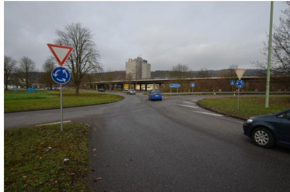
Abbildung 35: Wartelinie (Z 341 bei Vorfahrt gewähren) ist hier am Ende der Ausfahrrampe nicht mehr erkennbar
