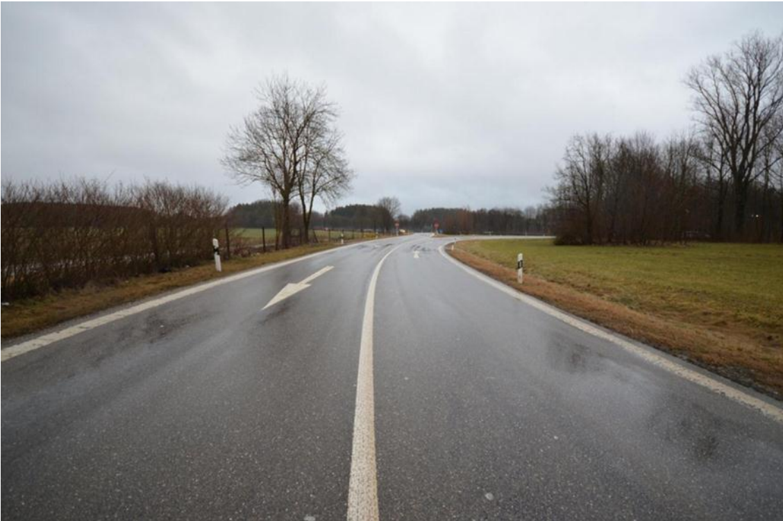
Abbildung 66: Beispiel für ungünstige optische Linienführung von Ein-/Ausfahrrampen - Mögliche Alternative? (Foto: Leven/Seipel)
