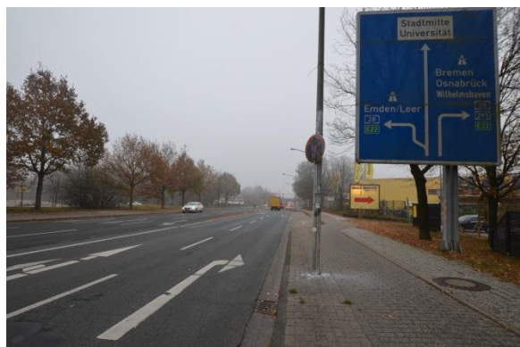
Abbildung 31: Wegweiser zur Autobahn (Z 440) veraltet und durch Verschmutzung in schlechtem Zustand
