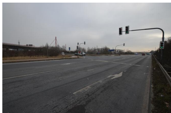
Abbildung 37: Pfeilmarkierungen (Z 297) sind durch starke Abnutzung nicht mehr erkennbar
