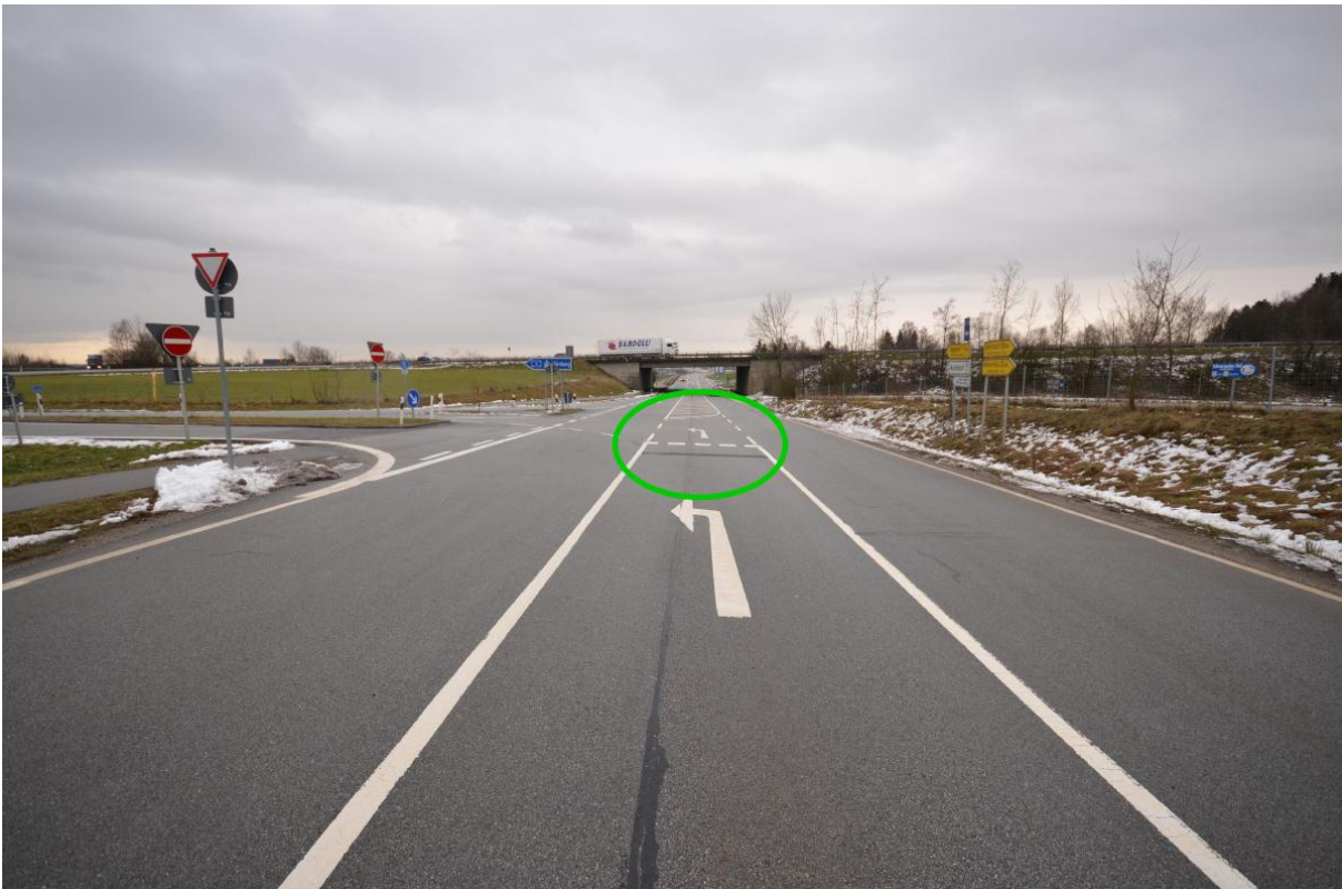
Abbildung 62: Optimierte Markierung an Anschlussstellen Ansicht 1 (Foto: Leven/Seipel)
