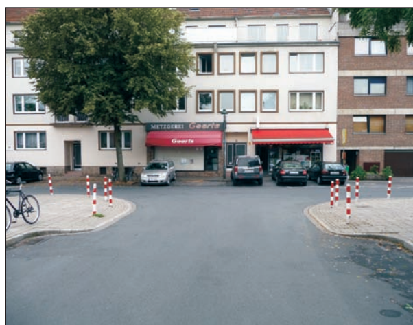
Bild 21: Überquerungsstelle ohne Vorrang mit vorgezogenen Seitenräumen
