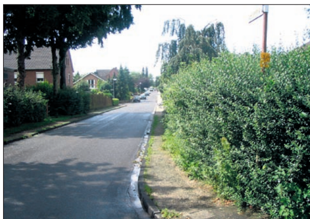
Bild 48: Gehwegbehinderung durch Bepflanzung
