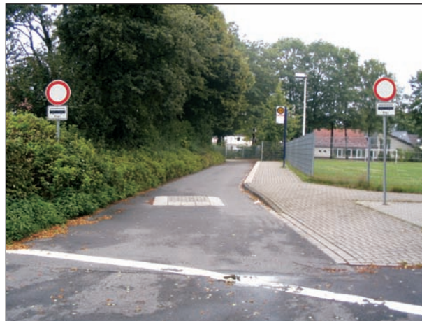
Bild 17: Haltestelle an der Schule: Ausbildung als „Schleuse“, dadurch keine Gefährdung durch Kfz bei Straßenüberquerung
