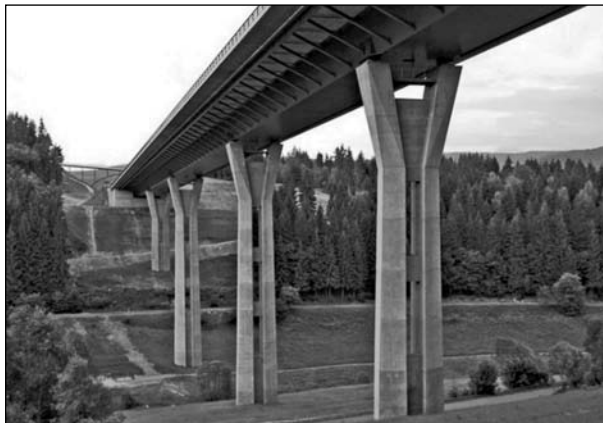
Bild 50: Talbrücke Dambach (Quelle: www.structurae.de)
