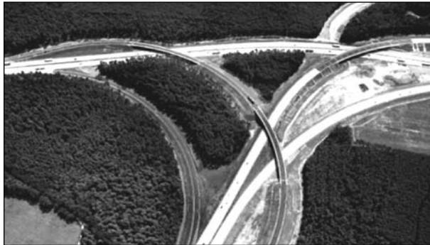
Bild 46: Nuthetalbrücke (Quelle: www.pnn.de)
