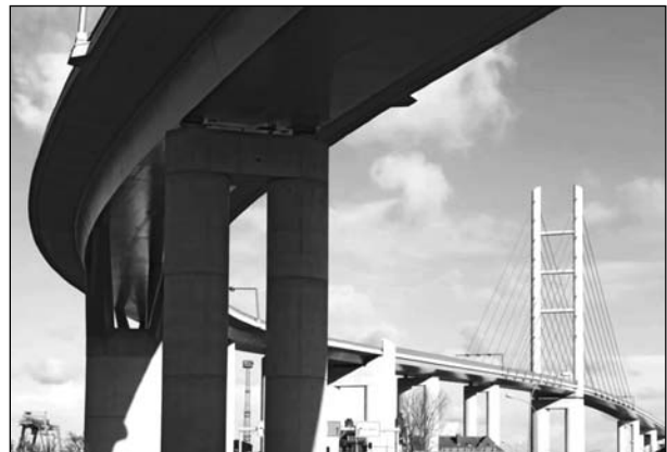
Bild 53: Ziegelgrabenbrücke (Quelle: www.ssf-ing.de)
