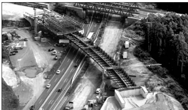
Bild 47: Nuthetalbrücke im Bauzustand (Quelle: MAYER & SCHUBART)
