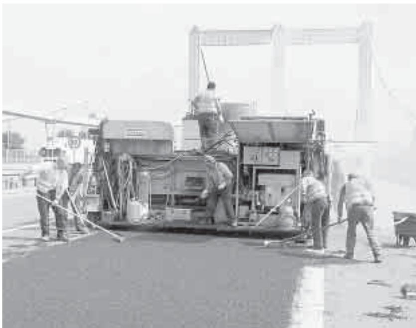
Dazu führte die BAST im Rahmen von Laborexperimenten Untersuchungen zur Auswirkung von Additiven und modifizierten Bindemitteln auf die Gebrauchseigenschaften von Gussasphalten für den Straßenbau durch. Außerdem wurden zwei Versuchsstrecken mit modifiziertem Gussasphalt errichtet. Die BAST führt hier beim Einbau und nach längerer Liegezeit Messungen durch.
