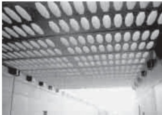
Rasterdecke aus selbstverdichtetem Beton am Kappeler Tunnel an der B 31 Ost (Foto: Reinhard Rauner, Regierungspräsidium Freiburg)
