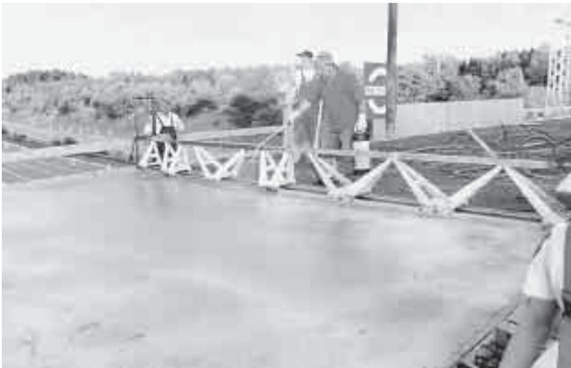
Mit der Rüttelbohle abgezogene Betonoberfläche - abgesprüht mit Nachbehandlungsfilm
