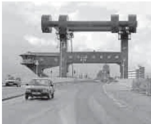
*Die Hydraulikanlagen der Peenebrücke Wolgast sind energiesparend im Maschinenhaus über der Fahrbahn untergebracht (Foto: Dürr, SBA Stralsund)*
