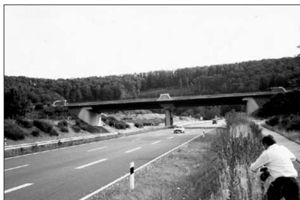
**Bild 3.2:** Verkehr auf der Straße: Spritzwasser trifft Schutzplanke und Pfeiler der Überführung und Sprühnebel trifft Pfeiler und Widerlager und ggf. den Überbau
