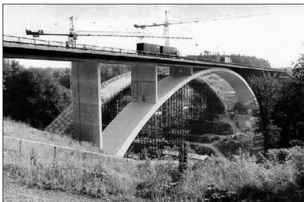
**Bild 3.1:** Verkehr auf einer Brücke: Spritzwasser trifft Brückenkappen und Sprühnebel trifft Überbau, Pfeiler und Bogen
