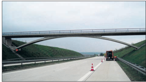
Bild 19: Gesamtansicht Brücke Wölkau
