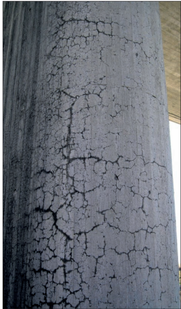
Bild 6: Stirnseite des Pfeilers mit Netzzissen
