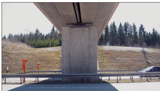
Bild 14: Gesamtansicht Pfeiler Achse 30, Ansicht von Nordwesten
