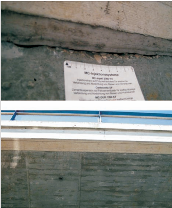
Bilder 10 und 11: Kragarm Überbau im Bereich der Kappe
