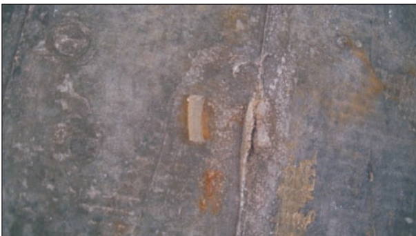
Bild 12: Abstandhalter an der Überbauuntersicht
