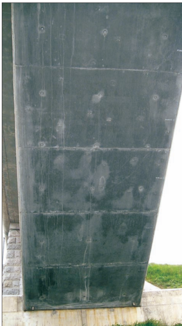
Bild 21: Dunkelfärbung Bogenstiel Achse 10
