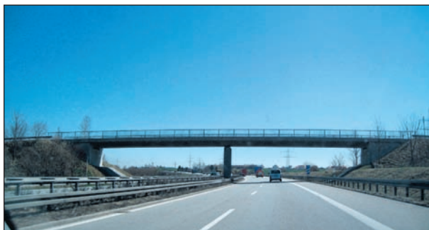
Bild 1: Ansicht Brücke Buchloe
