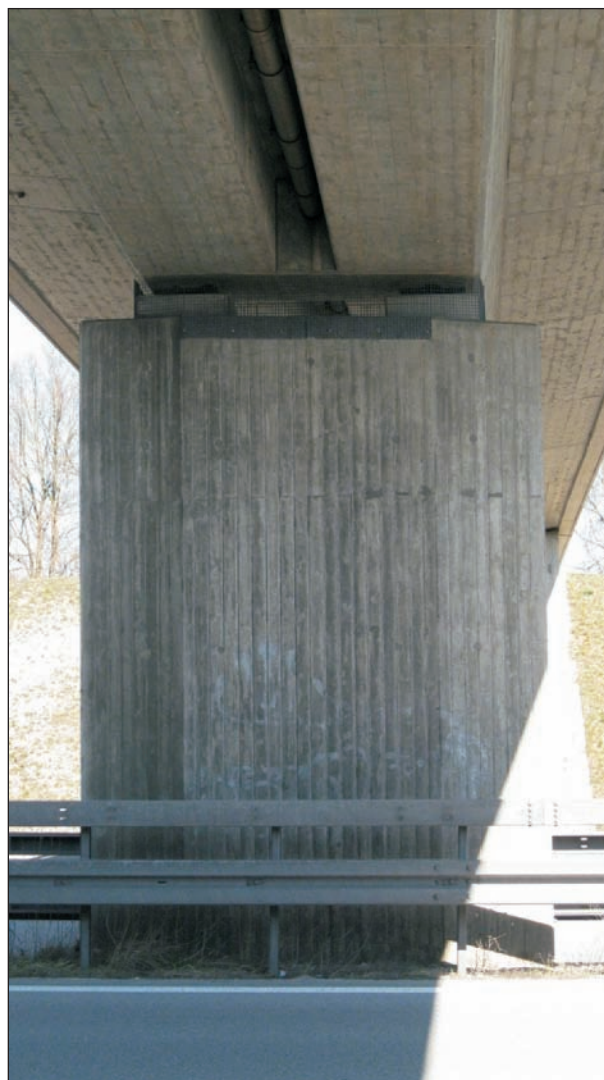
Bild 17: Gesamtansicht Pfeiler Achse 20 (B 35)
