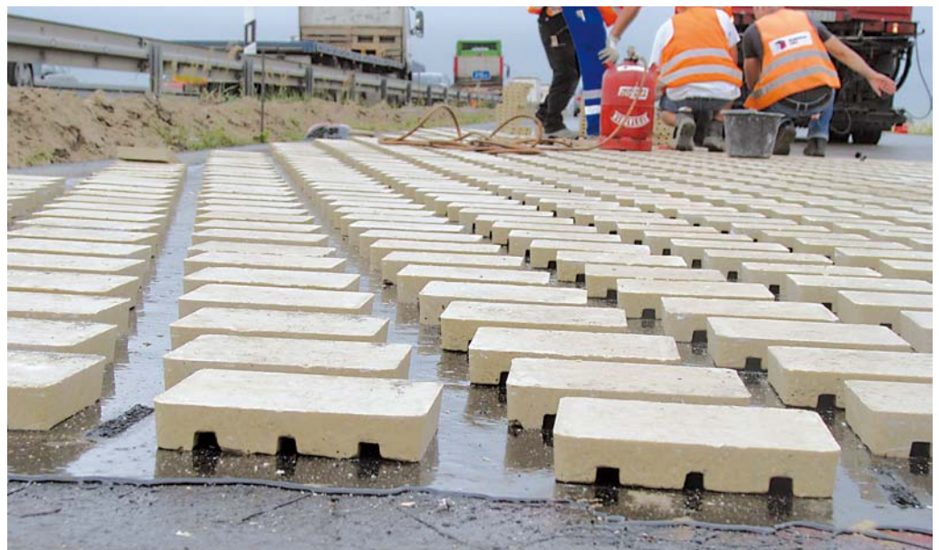
Einbau von Resonatoren auf der A 24 zur akustischen Optimierung offenporiger Asphalte
