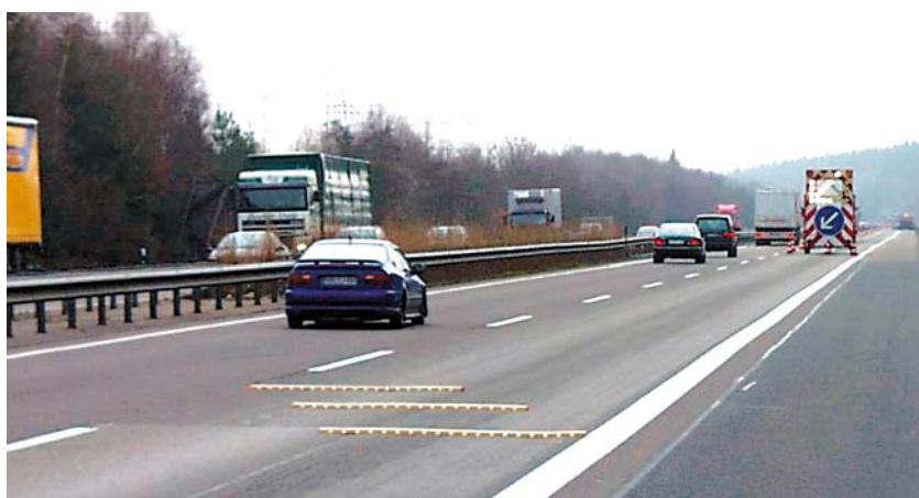
Einsatz von drei Warnschwellen vor einer Arbeitsstelle (Niederlande)
