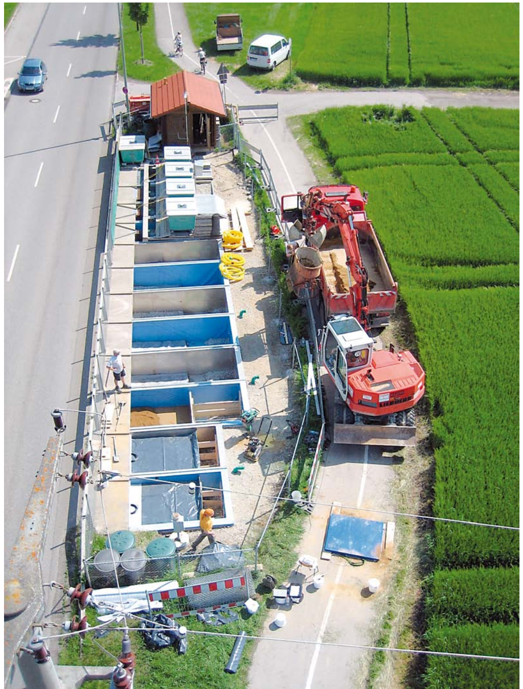
Lysimeteranlage zur Messung der Durchsickerung von Straßenböschungen – Einbau der Modellböschungen
