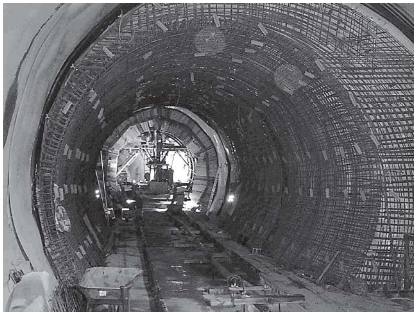
Schalwagen im Schlossbergtunnel
