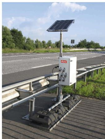
Die Stausensoren überwachen die Verkehrsdichte von Seitenstreifen, Mittelstreifen oder von Brücken aus. Jede Zentralsteuereinheit kann mit Detektoren ausgestattet werden.
