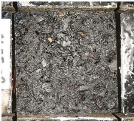
Bild 5: Abichtungssystem 1-1, Bruchart, Ansicht Unterseite abgerissener Stempel
