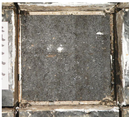
Bild 8: Abichtungssystem 3-1, Bruchart, Ansicht Probekörper
