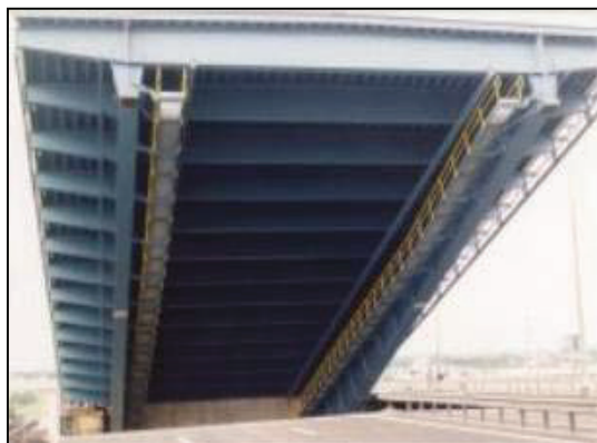
Bild 2: Beweglicher Teil der Brienoordbrücke
