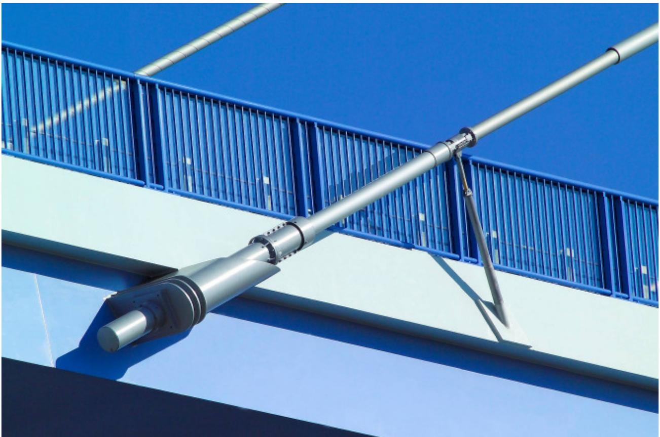
**Bild 8:** Dämpfer am Fußpunkt der beiden längsten Seilpaare
