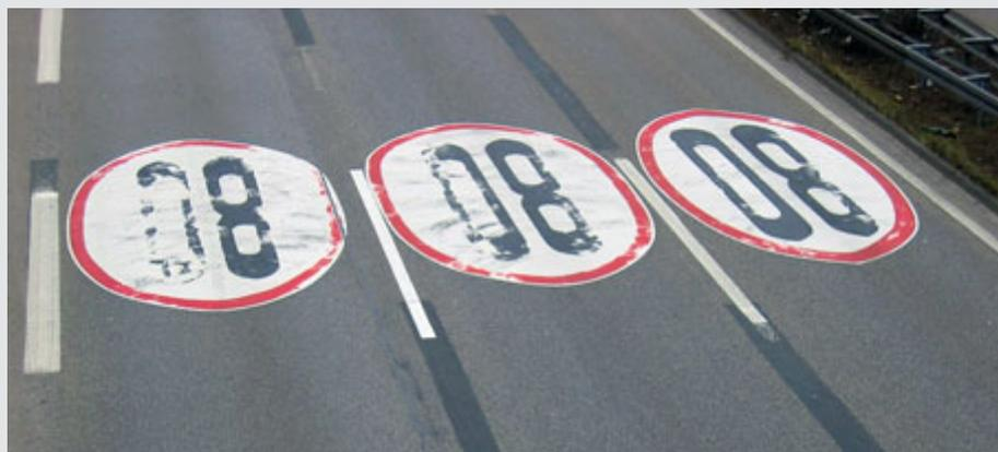
Bild 7: Markierte Verkehrszeichen unterliegen einem hohen Verschleiß
