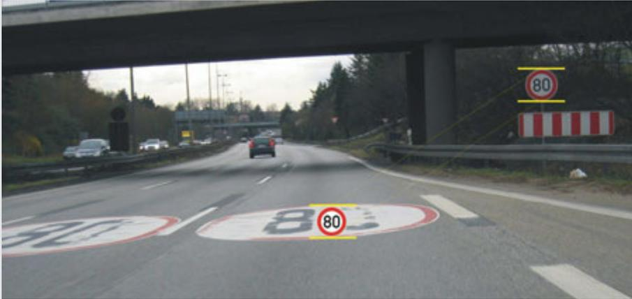
Bild 3: Beispiel zum Vergleich der Dimensionen von markierten und vertikalen Verkehrszeichen
