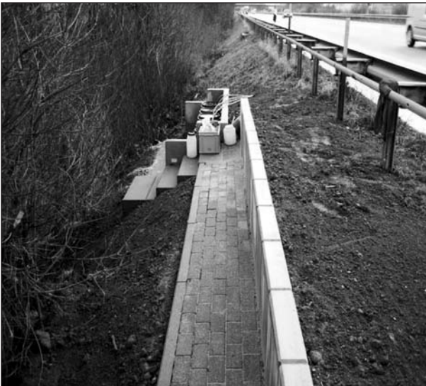
Bild 1: Standort A 61: Zugangsweg zum Abflusssammler
