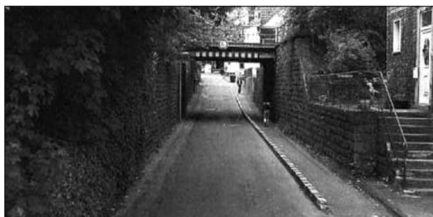
Bild 24: Ursachen für Engstellen – Unterführung
