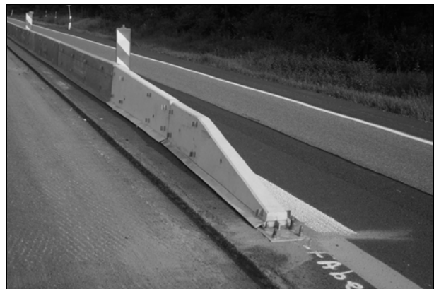
Bild 6.5: System Delta Bloc
