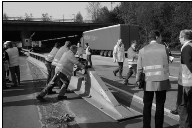
Bild 6.47: Verschwenken der Gate Guard
