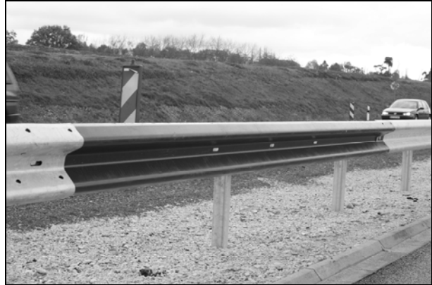
Bild 7.24: Holm mit Farbe beschichtet
