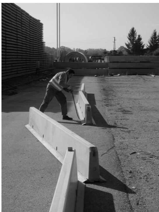
Bild 6.9: Verschieben des zweiten Elementes
