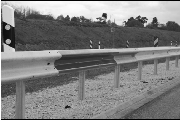
Bild 7.27: Holm mit Folie beklebt
