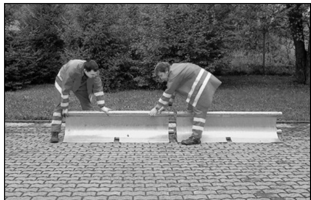
Bild 6.22: Steckverbindung
