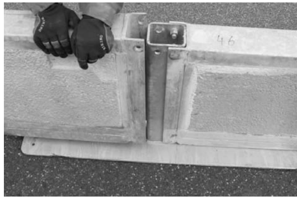
Bild 6.39: Montage des Systems Protec 120 [23]
