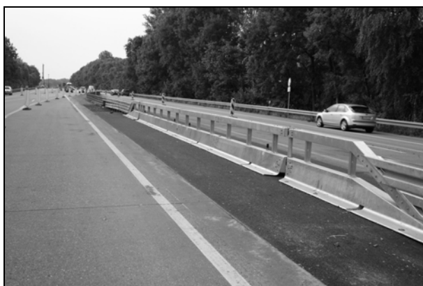
Bild 7.6: Beispiel für eine Notöffnung hinter dem Überleitungsbereich
