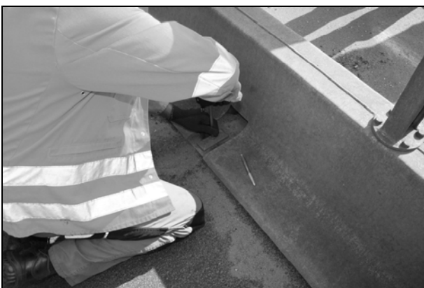
Bild 6.45: Lösen der Bodenverankerung
