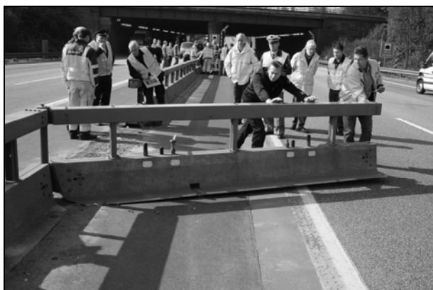
Bild 6.49: Öffnen des Notöffnungselementes
