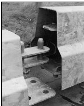
Bild 6.1: Schnellkopplungssystem einer Mini-Step Barrier
