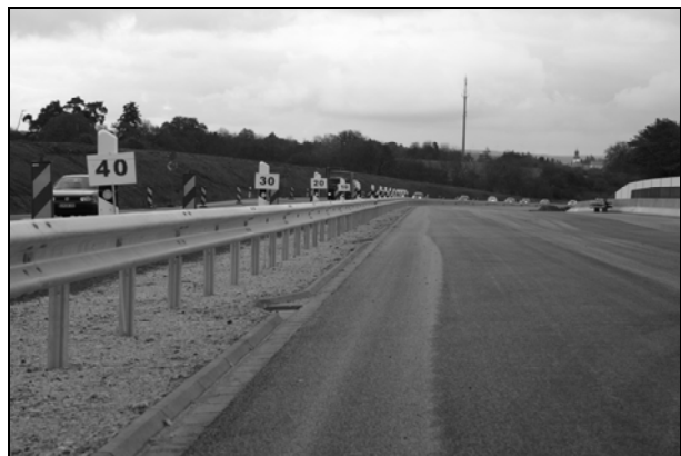
Bild 7.25: Farbbeschichtung auf 50 m Entfernung
