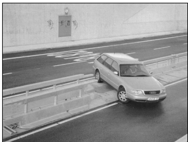
Bild 6.57: Geöffnete Vario-Gate [24]
