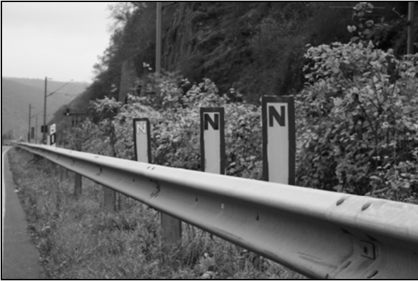
Bild 7.33: Leitfahnen ohne Schraffur mit unterschiedlichen Farben für die Schrift
