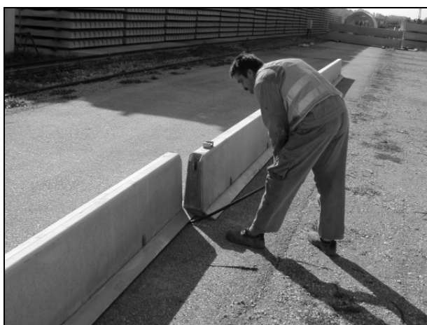
Bild 6.8: Aushebeln des ersten Elementes
