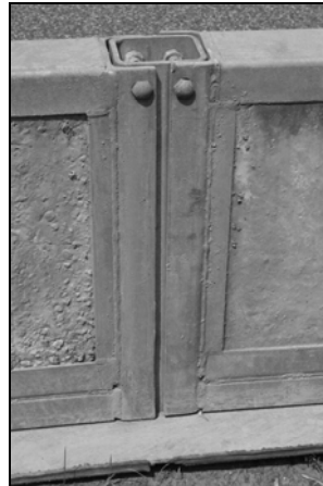
Bild 6.38: Verbindungsmechanismus Protec
