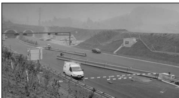
Bild 4.3: Geöffnete Mittelstreifenüberfahrt vor einem Tunnel
