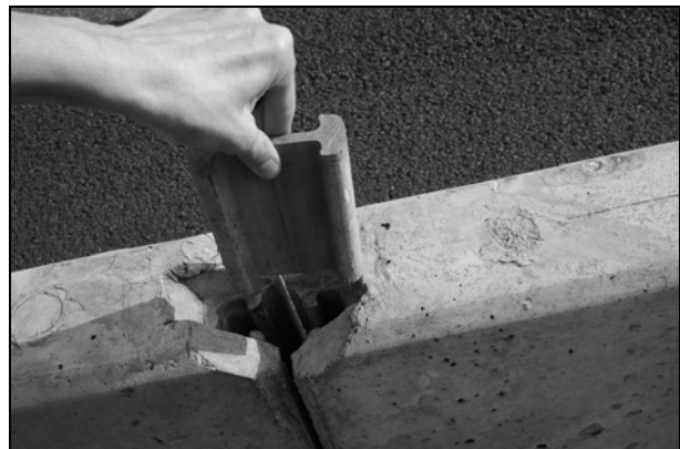
Bild 6.6: Kupplungselement
