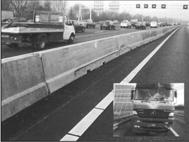
Bild 6.11: System Haitsma nach einem Lkw-Anprall [18]
