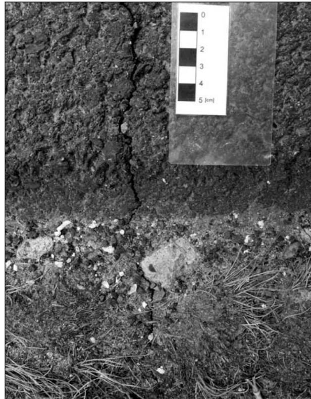
**Bild 40:** Rissaufnahme April 2010 – Querriss im Asphalt mit Fortsetzung im Bankett
