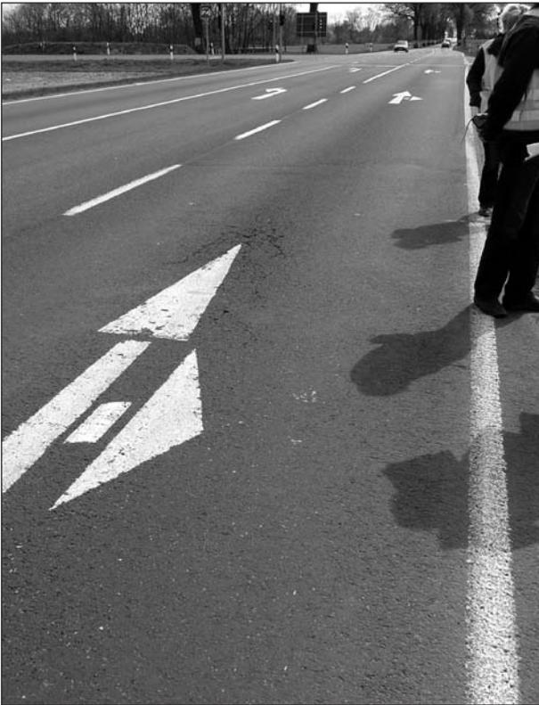
**Bild 39:** Rissaufnahme April 2010, Variante 5D – Netzrisse im Bereich der Richtungsmarkierung
