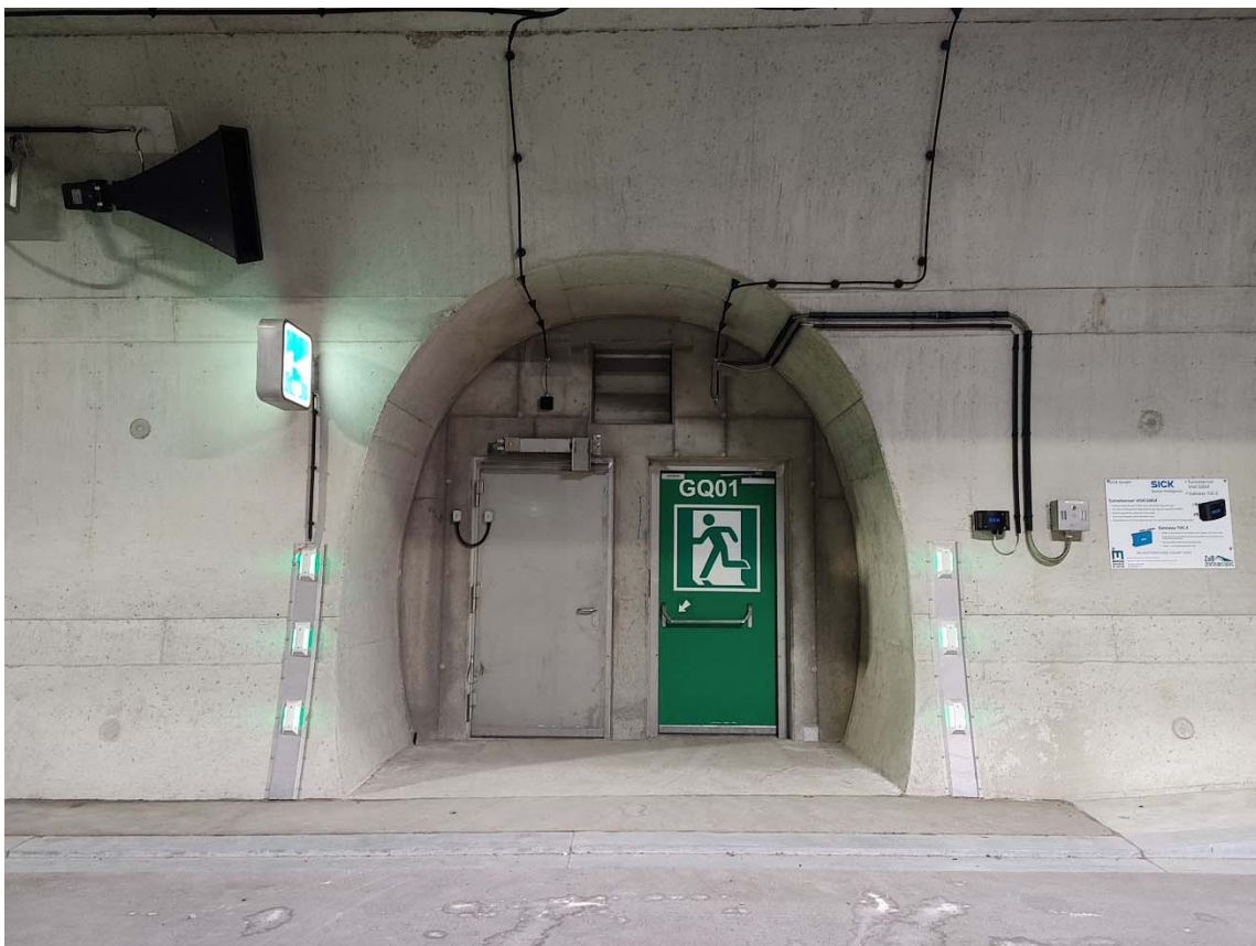
Bild 6: Nordröhre Straßentunnel: Notausgang zum Querschlag GQ01 im Bereich der Probandenversuche
