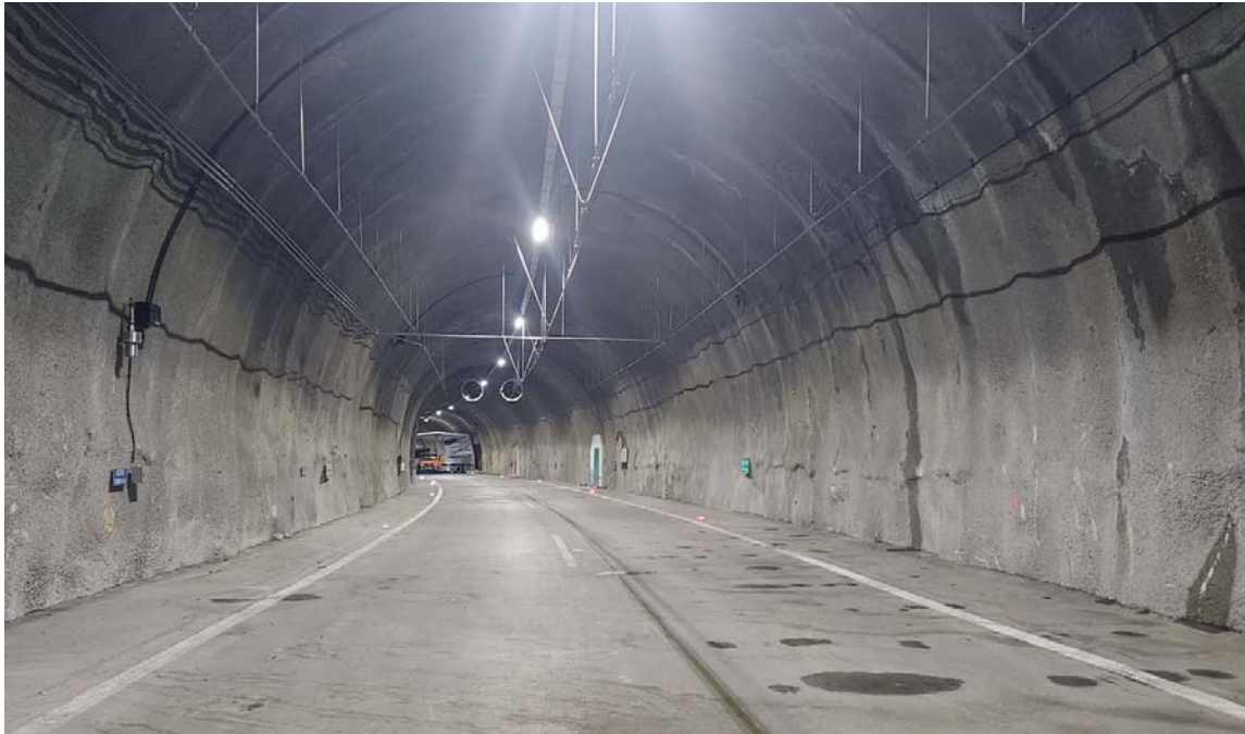
Bild 5: ZaB, Nordröhre mit Straßentunnel-Querschnitt, Perspektive der Probanden bei TM0145 bei Annäherung an den Unfallbereich
