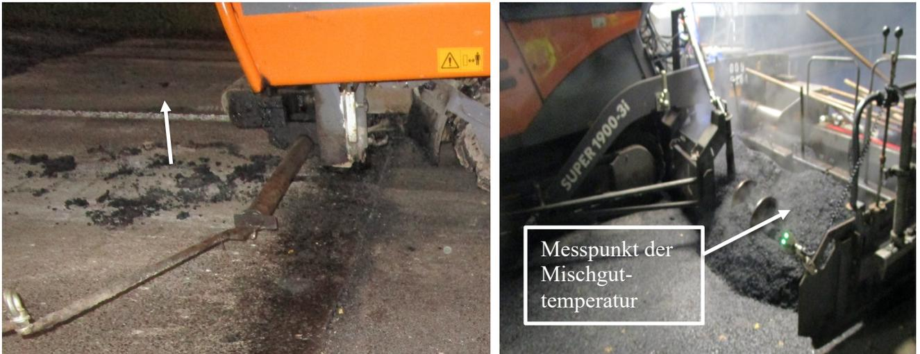
Bild 42: Messpunkte der Temperaturmessungen
