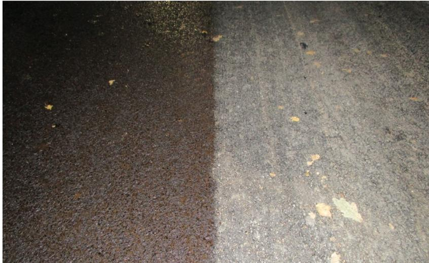
Bild 31: Vergleich angesprühter Bereich (links) und nicht angesprühter Bereich (rechts)
