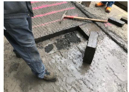
c) Entnahme der Platten
