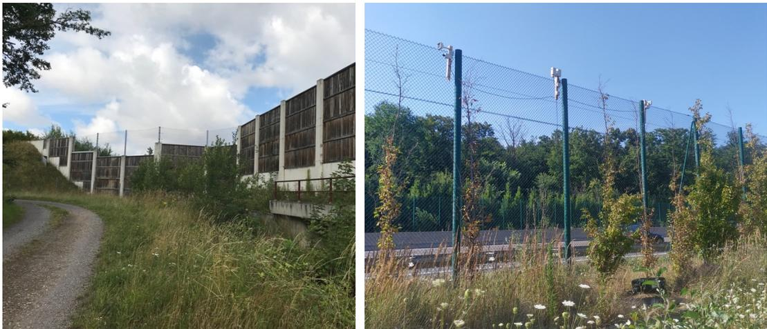
Bild 4-14: Überflughilfe am Standort E an einer Autobahn
