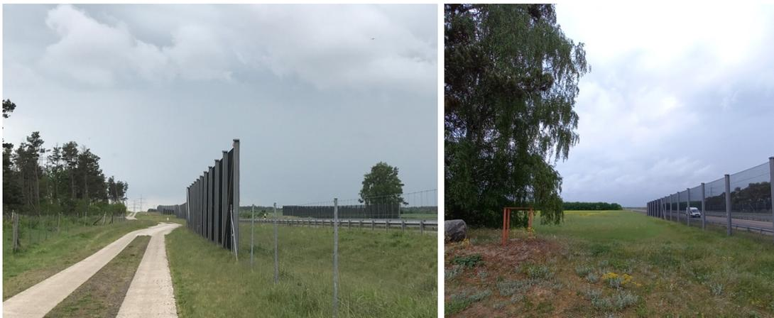
Bild 4-17 : Überflughilfe am Standort F an einer Autobahn
