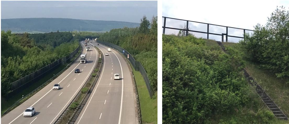
Bild 4-23: Überflughilfe am Standort H an einer Autobahn
