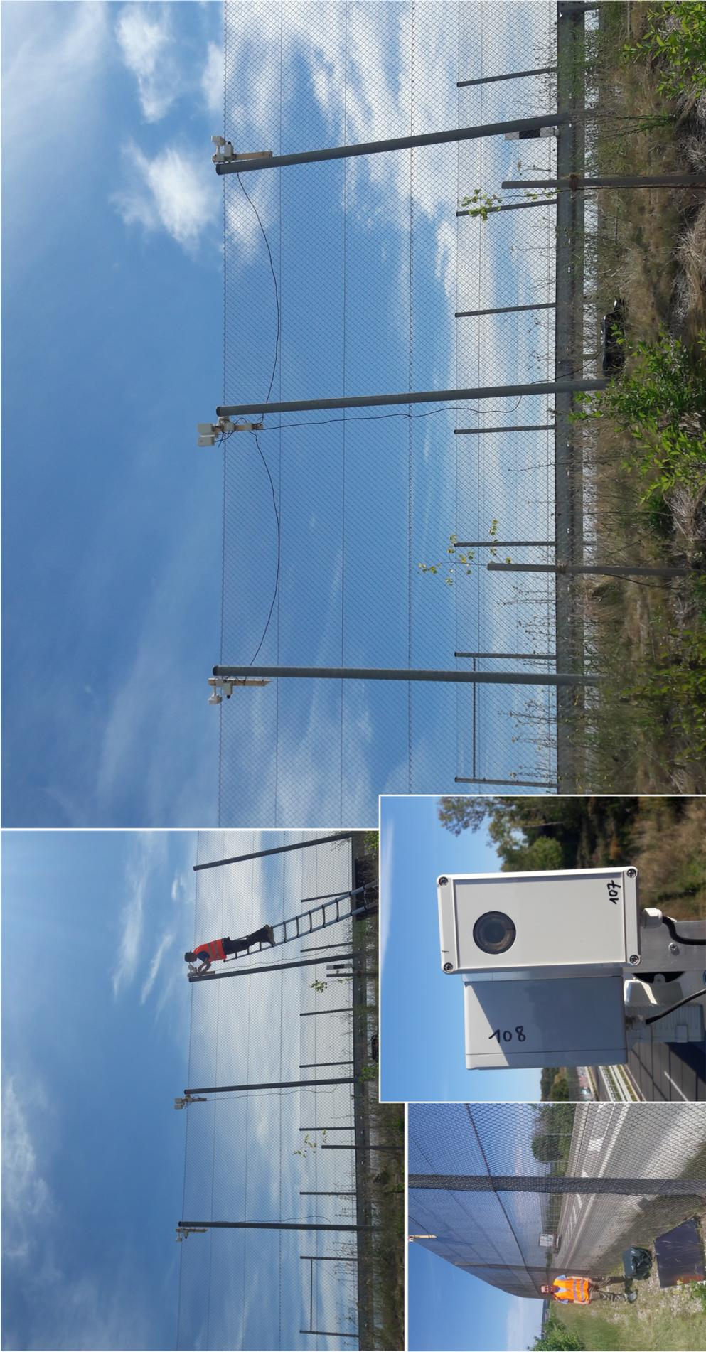
Bild 6-5: Installation der optisch-akustischen Erfassungssysteme an einem Standort. (Fotos: H. Reers & S. Radford)
