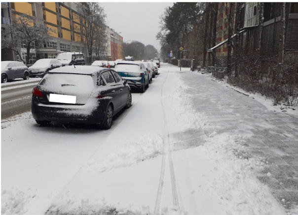
Bild 32: Zugeschobene Radwege durch geräumte Gehwege (Bild: MÄRZ)
