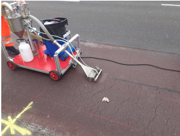
Bild 64: Spül-Saug-Gerät der Firma ESG (Bild: MÄRZ)
