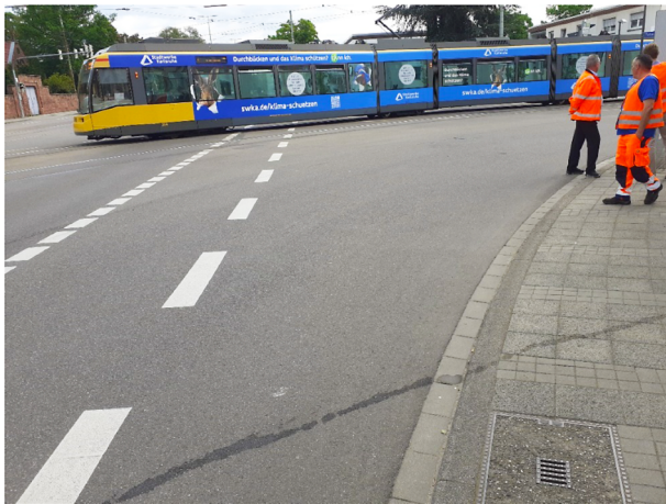
Bild 86: Großer Kurvenradius am Knotenpunkt Tullastraße (Bild: WIESLER)
