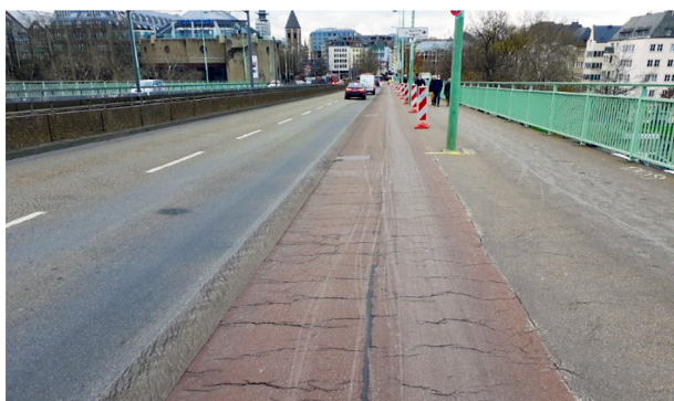
Bild 70: Fahrspuren des Radverkehrs auf der Deutzer Brücke in Köln (Bild: MÄRZ)
