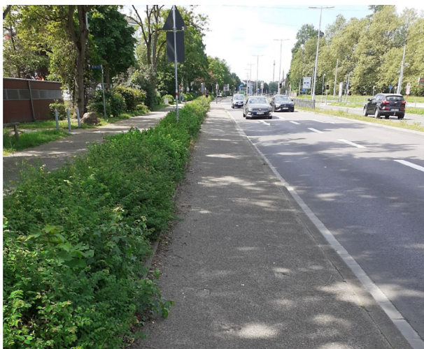
Bild 85: Baulicher Radweg mit Hochbord zwischen den Knotenpunkten Hirtenweg und Ostring (Bild: WIESLER)
