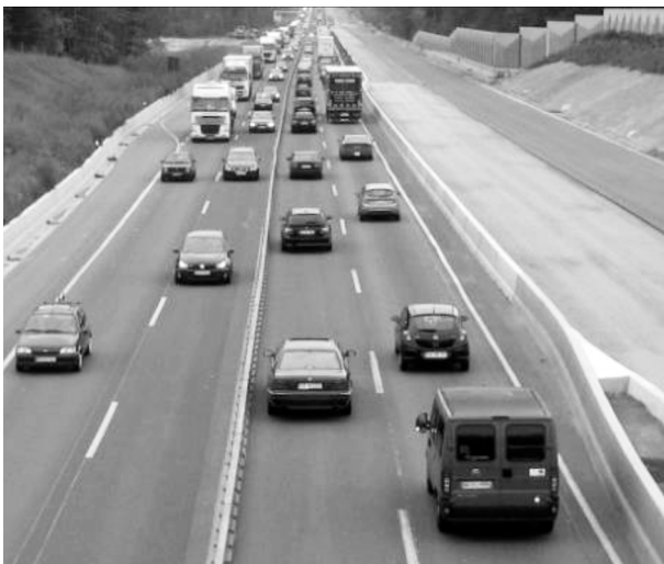
Bild 3-16: Standort B: Bereich mit Baustelle der Untersuchungsstrecke Bönen (A 2)
