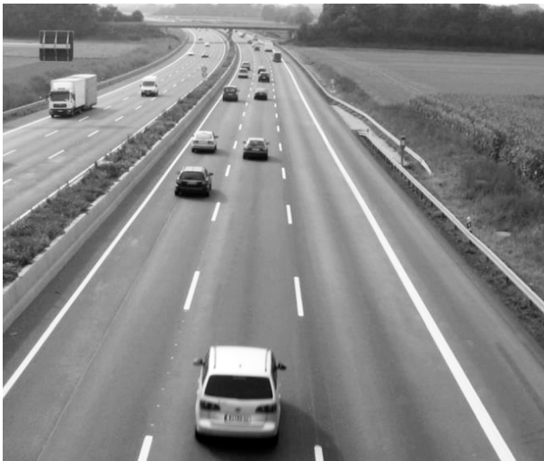
Bild 3-15: Standort A: Bereich ohne Baustelle der Untersuchungsstrecke Bönen (A 2)
