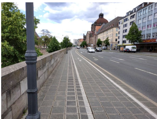
Bild 2E: Führung im Seitenraum: Zweirichtungradweg
