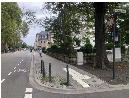
Bild 2C: Führung auf der Fahrbahn: Schutzstreifen
