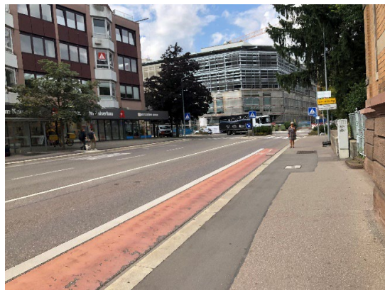
Bild 2B: Führung auf der Fahrbahn: Radfahrstreifen
