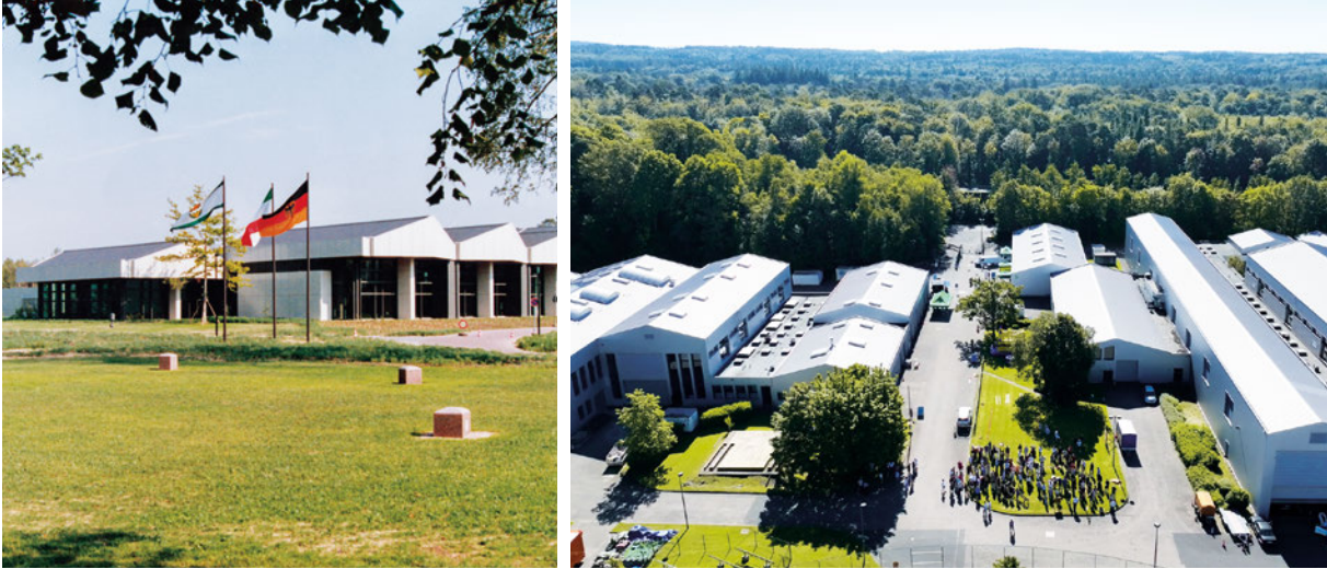
Alte Aufnahme der BASt und neue Versuchshallen.
