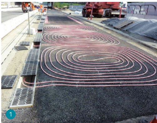
1 Einbau der Technik in die Fahrbahn 2 Die Technologie hält die Straße im Winter frei von Schnee und Eis.
