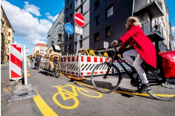
**Bild 1-1: Good Practice-Beispiel für eine sichere Radverkehrsführung in Arbeitsstellen in Berlin (SENUVK o.J.)**
